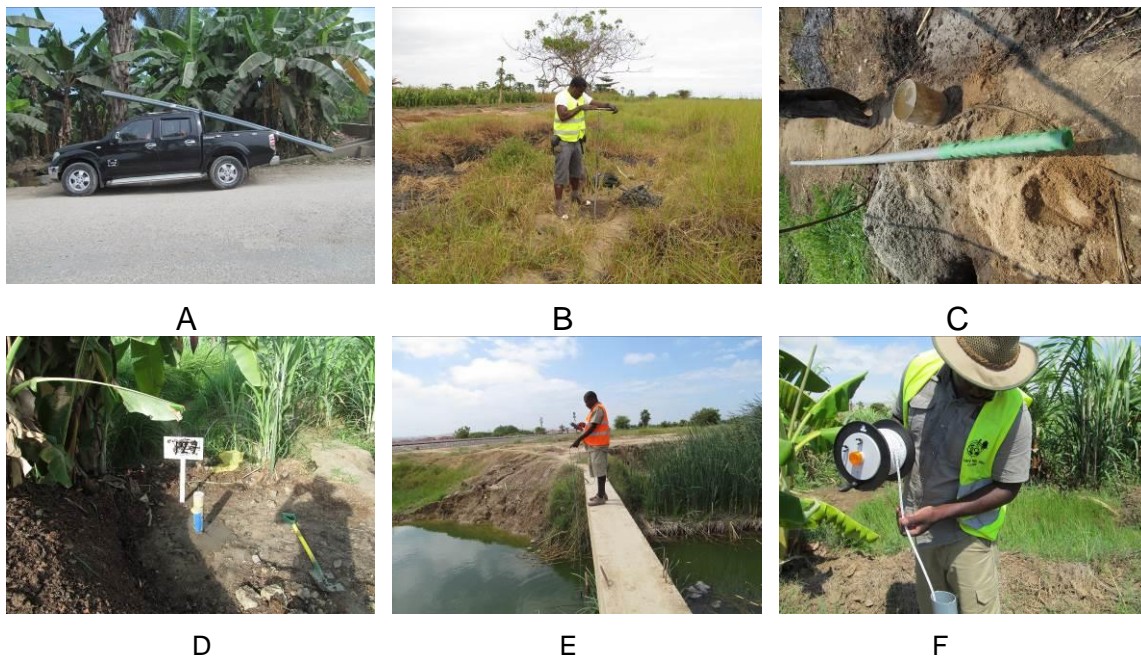
Figura 3. 2. Ilustração parcial do processo de instalação de piezómetros(A-transporte de material para o campo; B-Furação a trado manual; C – Instalação do tubo encamisada; D – Proteção e sinalização do Piezómetro) e medições in situ da água; E – Medição dos parâmetros físico-químicos com o multiparamétrico de água; F – Medição do nível de água com a sonda acústica.
