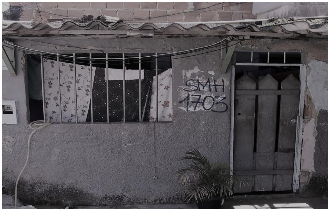
Figura 18. Casa do Morro da Providência 93 marcada para remoção.
