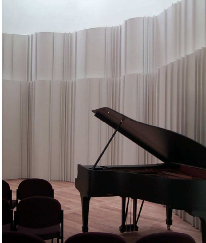
Figura 2.34 – Aplicação de difusores numa parede côncava [1].
