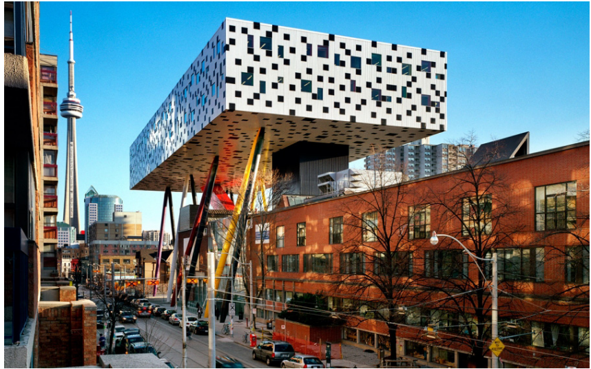
FIGURA 35 Edifício da OCAD University, Toronto.
