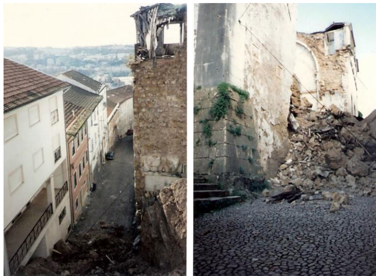
Figura 1.2- Desabamento da parede sul do antigo Colégio da Trindade no ano de 1988 (Fonte: Otávio Sérgio, publicado no blog, Guitarra de Coimbra ).
