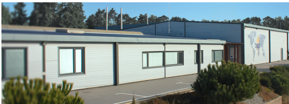
Fig. I – Visão exterior das instalações dos laboratórios BASI.
