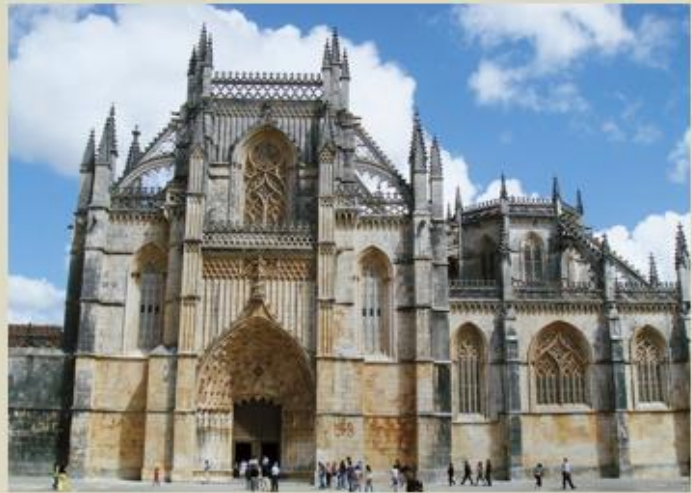
Mosteiro de Santa Maria da Vitória (ou da Batalha)
