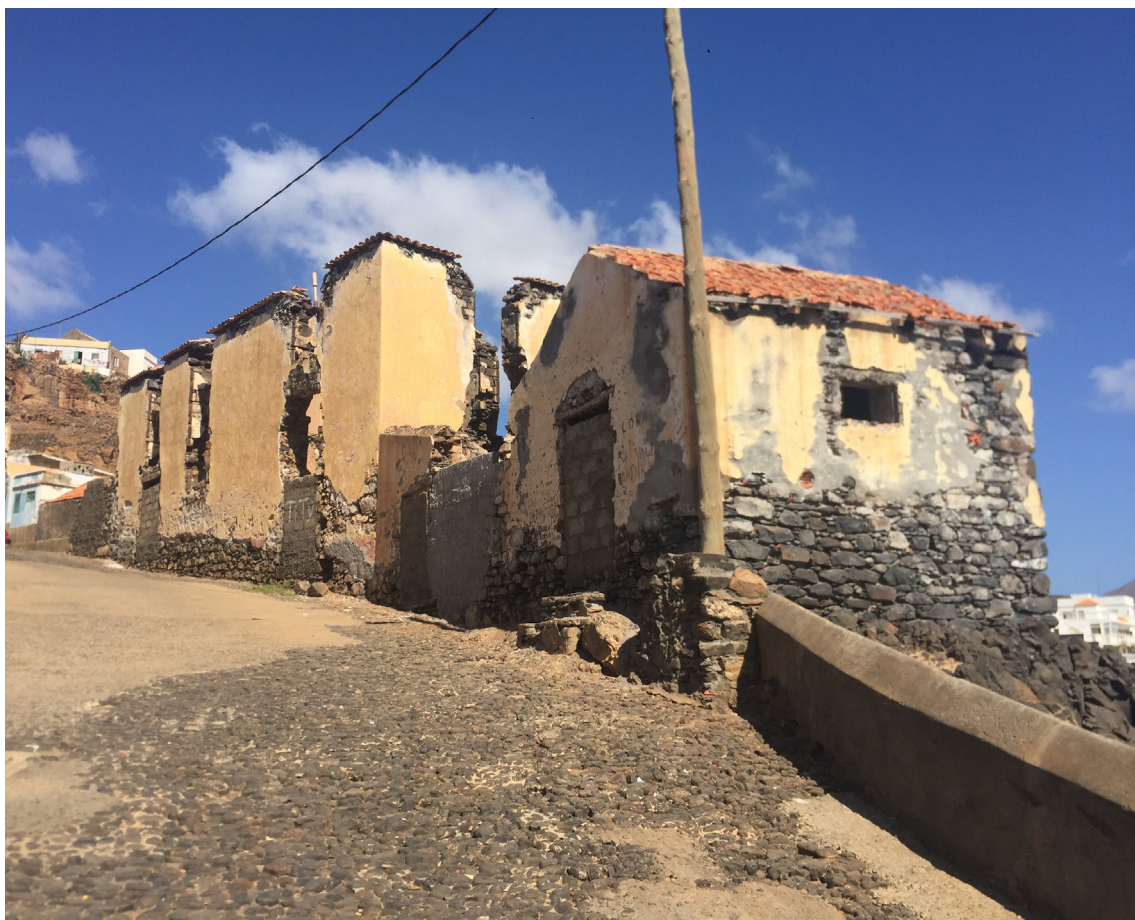
Estado atual do edifício da antiga alfândega
