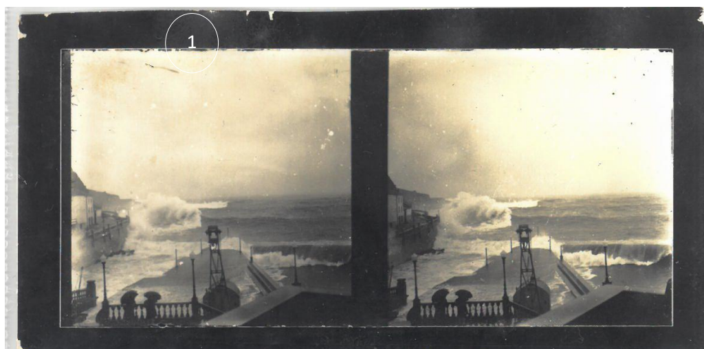
Figura 2-26 - Cais da Alfândega (mau tempo). @Arquivo fotográfico da DRAC.
