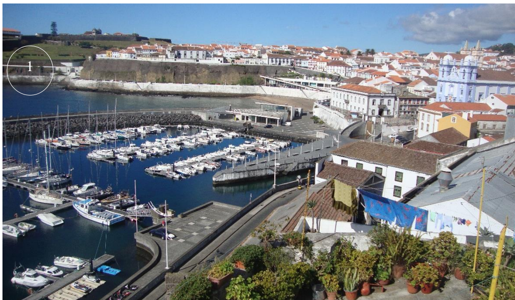
Figura 2-32 - Vista do Cantagalo. @Arquivo fotográfico da DRAC.
