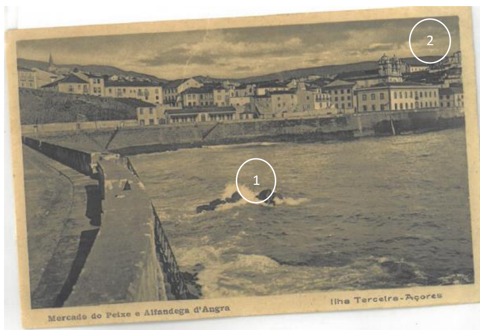
Figura 2-21 - 1 - Prainha e 2 - Edifício da Alfândega (Fins do século XIX). @Arquivo fotográfico da DRAC.
