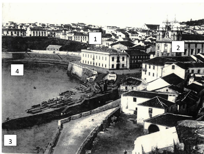
Figura 2-12 - Baía de Angra: 1 - Edifício da Alfândega; 2 - Igreja da Misericórdia; 3 - Cais de Alfândega; 4 - Prainha. @Arquivo fotográfico da DRAC.
