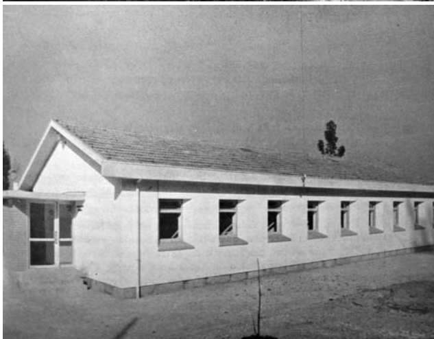
Fig. 965: . s/a. s/d. Porto - Sanatório-Hospital "Rodrigues Semide", 1961. ID_CD: 143-Porto-Sanatório-Hospital _Rodrigues Semide_Page_08.jpg
