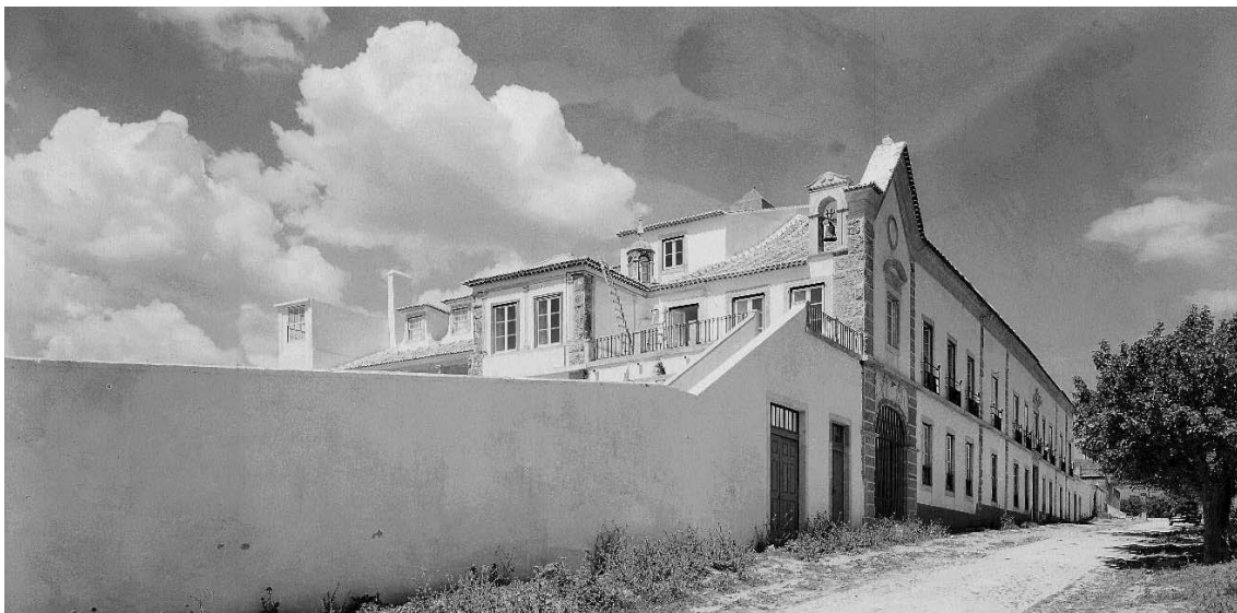
(Sanatório da Flamenga. SIPA: FOTO.00542702, s/d)
