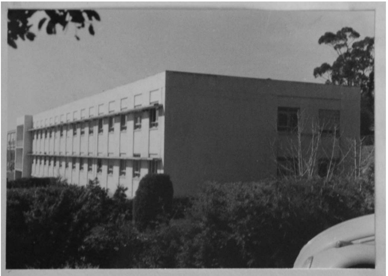
Fig. 853: Aspecto do acesso ao sanatório. DGCH, s/r.
