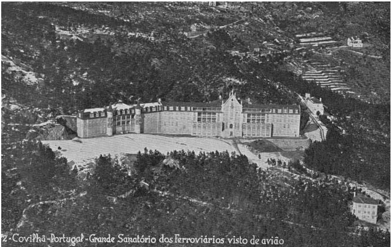
Fig. 935: Vista geral. ILFOTO, s/r, s/d. ID_CD: SFERROVIARIOS-0785.jpg
