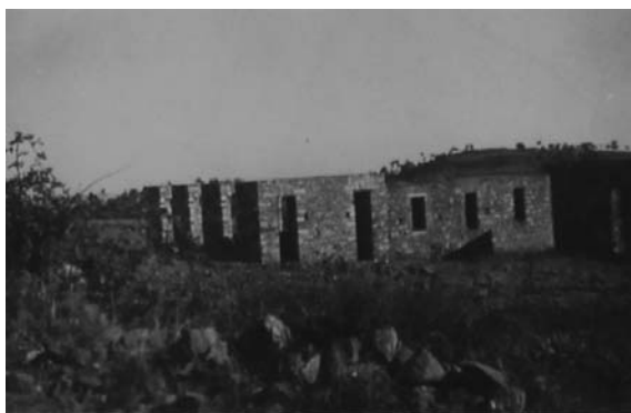
Fig. 809:Levantamento fotográfico com existente. (...). s/a. s/d. SIPA: s/r (não catalogado). ID_CD: FOTO_SemRef_Montachique (1).JPG Fig. 810:Levantamento fotográfico com existente. (...). s/a. s/d. SIPA: s/r (não catalogado). ID_CD: FOTO_SemRef_Montachique (2).JPG Fig. 811:Levantamento fotográfico com existente. (...). s/a. s/d. SIPA: s/r (não catalogado). ID_CD: FOTO_SemRef_Montachique (5).JPG Fig. 812:Levantamento fotográfico com existente. (...). s/a. s/d. SIPA: s/r (não catalogado). ID_CD: FOTO_SemRef_Montachique (7).JPG Fig. 813:Levantamento fotográfico com existente. (...). s/a. s/d. SIPA: s/r (não catalogado). ID_CD: FOTO_SemRef_Montachique (8).JPG
