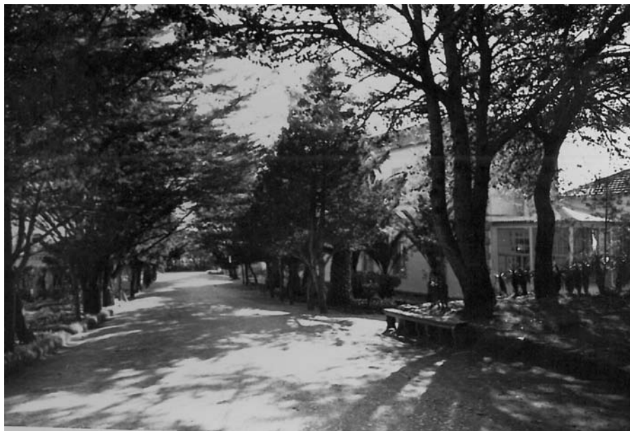
Fig. 328: Enfermaria. s/a. s/d. SLAT: s/r. ID_CD: SCARCAV-0352.jpg
