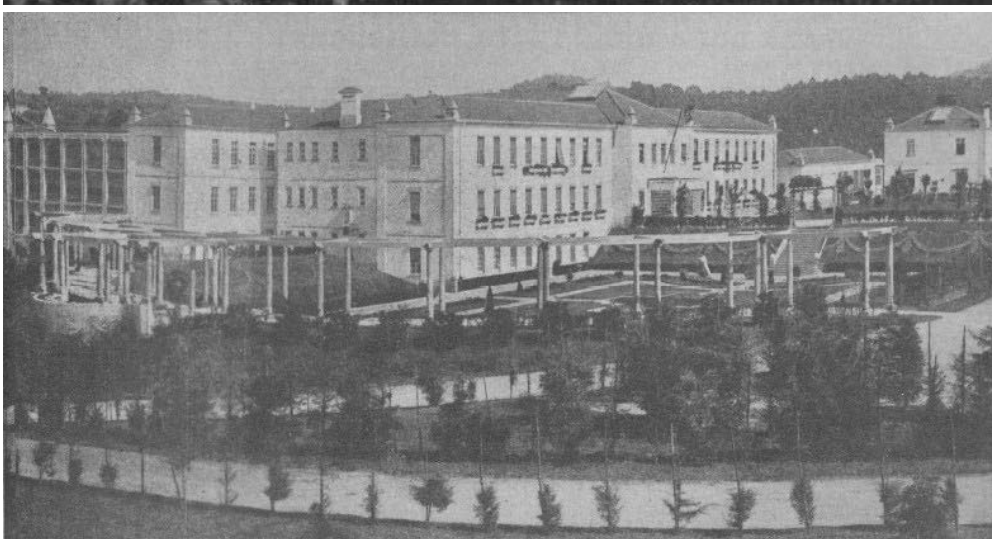
Fig. 1235: Vista aérea. s/a. s/d. CDBB: FEA01010.jpg. ID_CD: SCOVOES-0766.jpg
