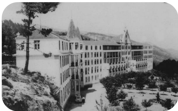
Sanatório dos Ferroviários 17
