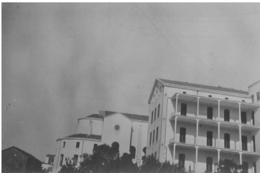
Fig. 1141: Vista lateral, com galerias de cura. s/a. s/d. SIPA: . ID_CD: FOTO_347148.JPG.
