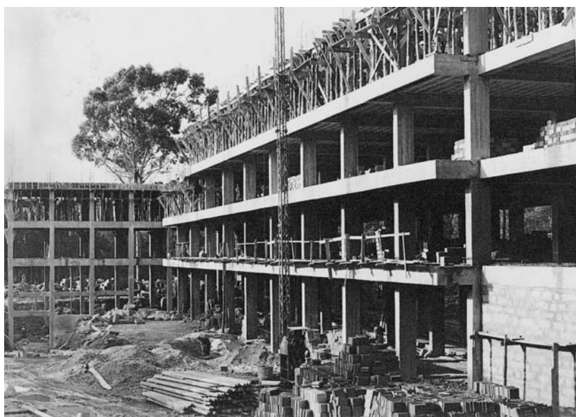
Fig. 1083: Fotografia de obra. s/a. 1963. SIPA: FOTO.00134686. ID_CD: SDMI-88.jpg
