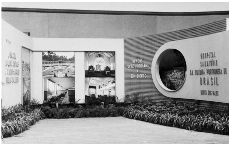
Fig. 1255: Galeria de cura. s/a. s/d. DELC: FEA01013_A.jpg. ID_CD: 232_001.jpg
