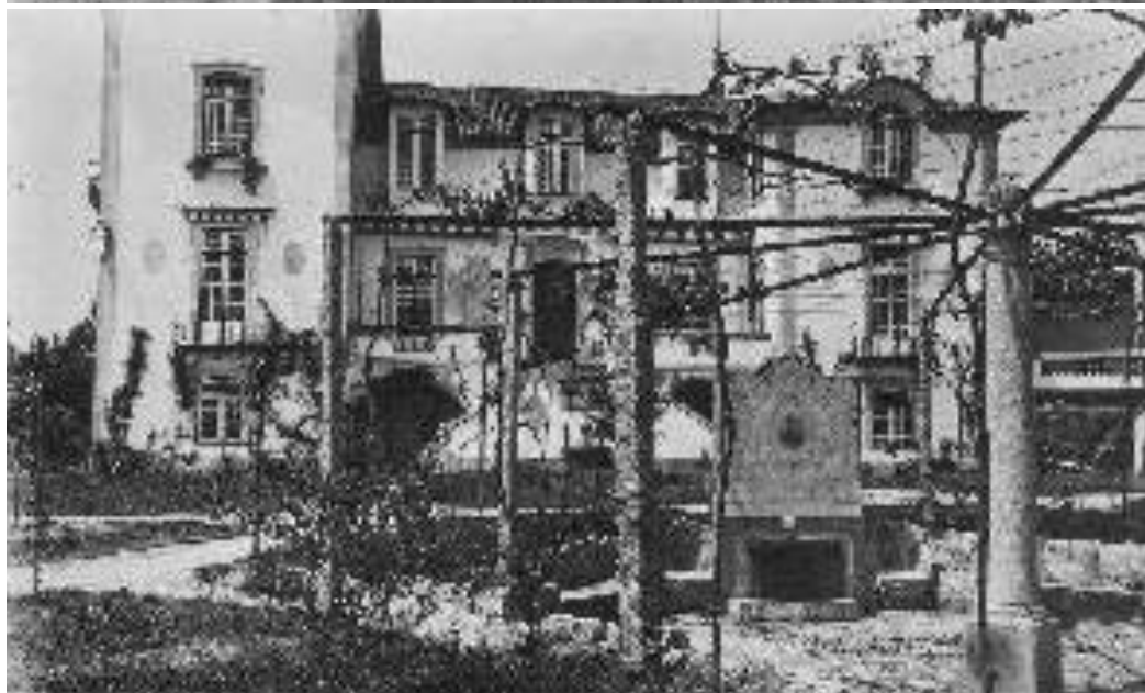
Fig. 824: Estância de Louredo da Serra - Aspecto Geral. Estância de Louredo da Serra – Paredes, http://coleccionar-collectus.blogspot.pt/2007/09/estancia-de-louredo-da-serra-paredes.html , s/d. ID_CD: 1.jpg
