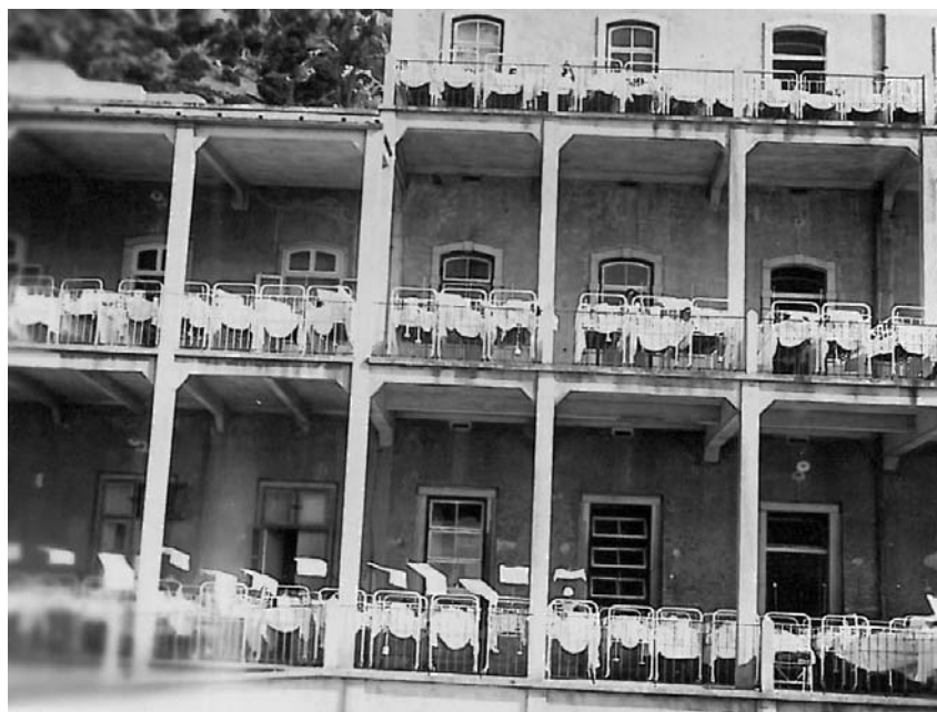
Fig. 361: Sanatório do Outão - Galerias de cura. s/a. s/d. Carvalho - "La situation actuelle" in La lutte contre la tuberculose au Portugal, 1936.. ID_CD: IMAGEM_733.JPG
