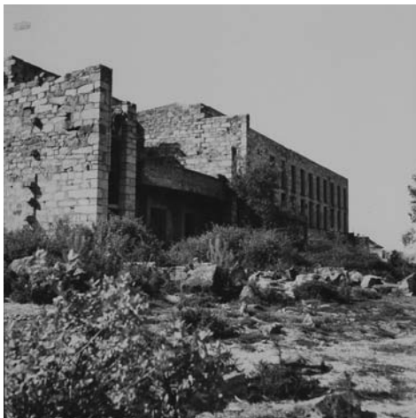
Fig. 833: Levantamento Fotográfico: Foto 4. s/a. s/d. SIPA: s/r. ID_CD: FOTO_349941.JPG
