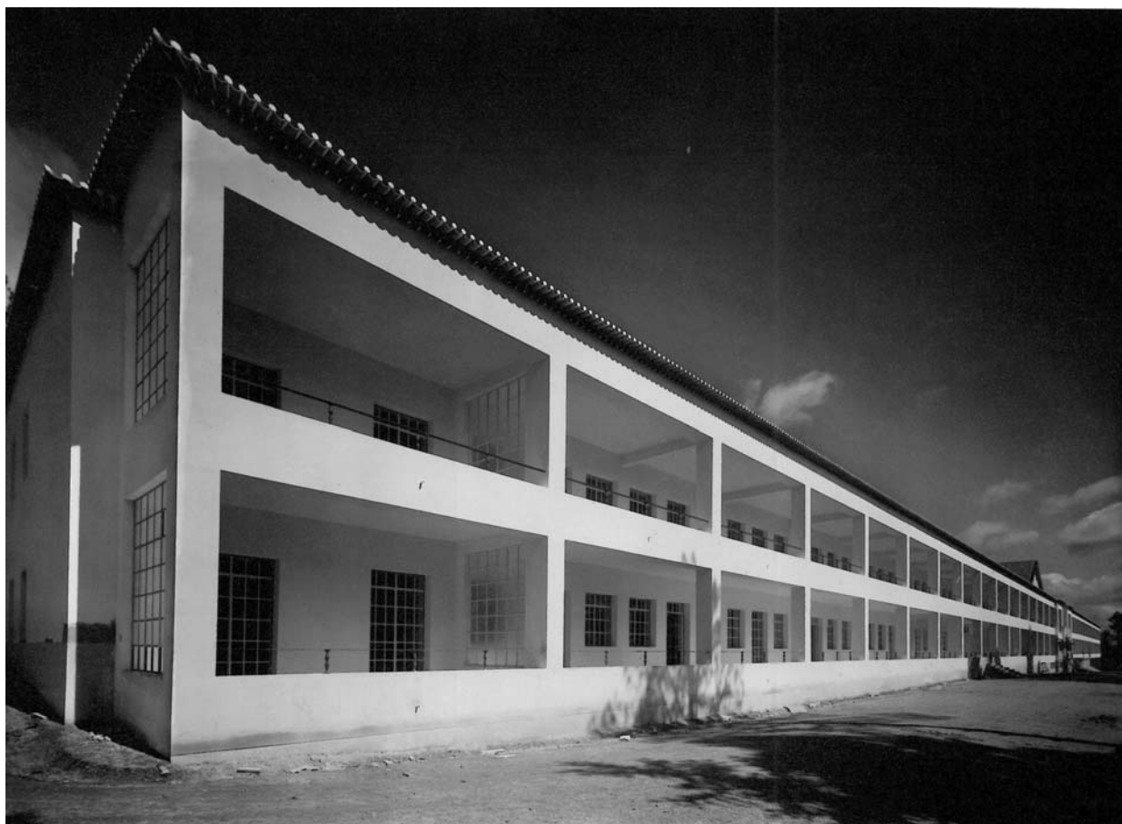
Fig. 158: Pav. 300 camas. s/a. s/d. SLAT: s/r. ID_CD: SSM-0149.jpg
