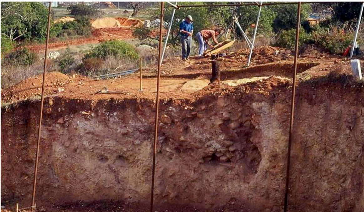
Fig. 3.4 – O corte realizado aquando da abertura de um arruamento possibilitou a identificação da depressão ulteriormente identificada como o hipogeu de Monte Canelas I. Fotografia de Rui Parreira.
