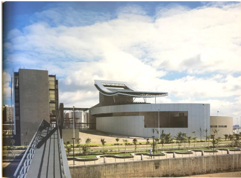
Figura 59 - Vista geral do passadiço
