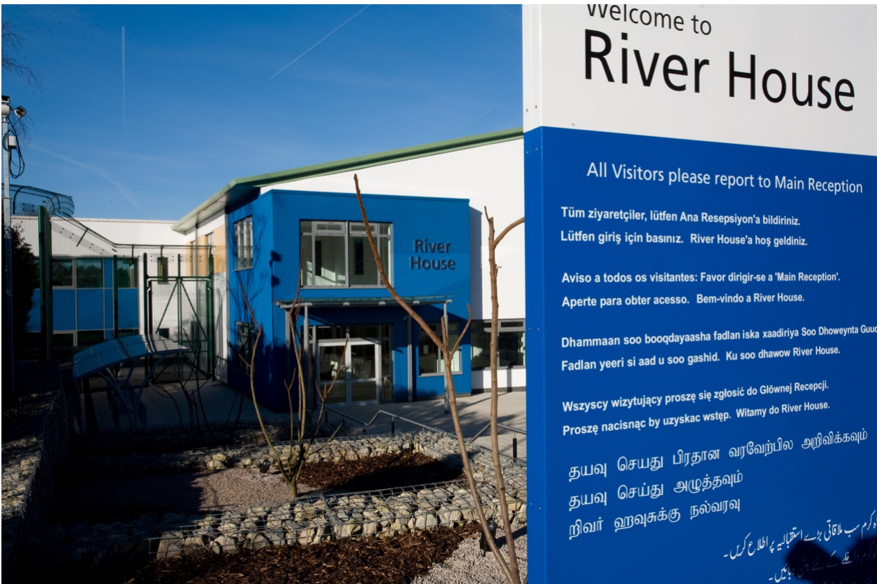
Figura 55. Acesso Principal da River House, onde recebem os pacientes externos e os visitantes. Galeria do Hospital de Bethlem, Beckenham, 2016
