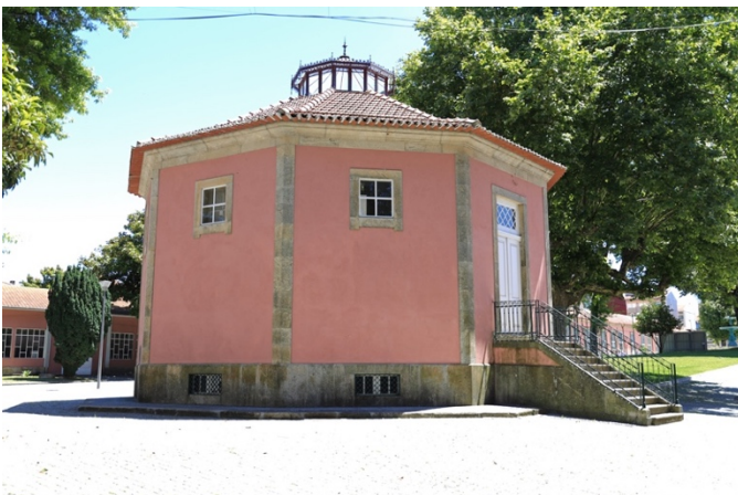
Figura 29. Panóptico do Hospital de Conde de Ferreira Porto, 2017.
