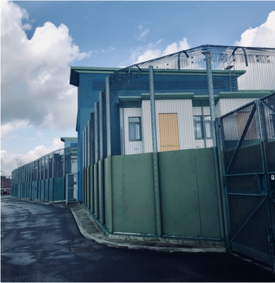
Figura 54. Acesso Secundário da Unidade de média segurança de Psiquiatria Forense, chamada River House . Nesta entrada é possível ver uma vedação em malha de aço suportada por ferro.
