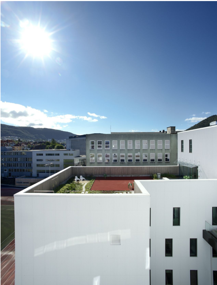
Figura 66. Vista do piso 06 a partir do terraço-jardim do Hospital de Kronstad Portfólio do Gabinete de Arquitetura do Grupo Origo, 2016
