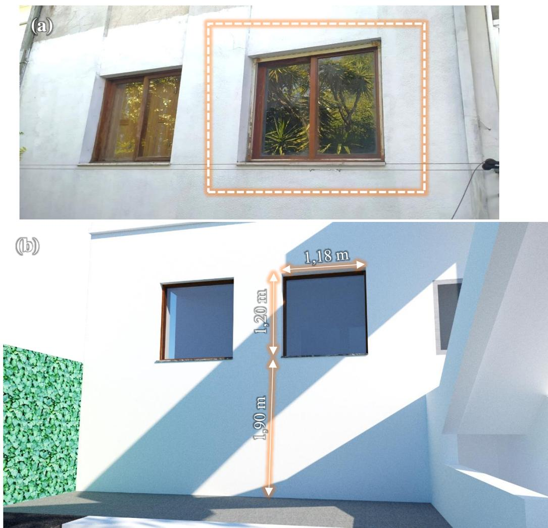
Figura 4.2 - (a) fotografia do caso de estudo, correspondente à área em torno da janela à direita; (b) esquematização do caso de estudo e dimensões relevantes.
