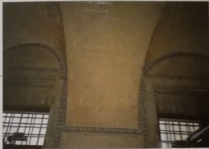
7—Muro oeste da cozinha.
