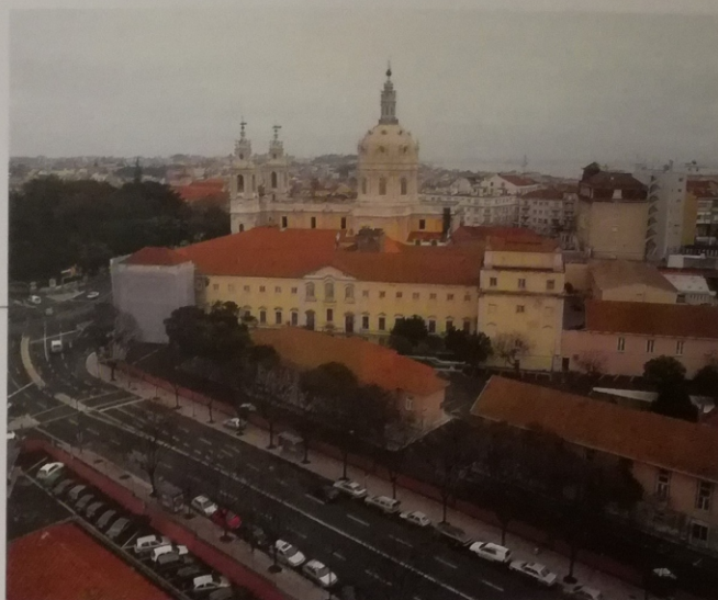
①—Vista geral sobre o alçado oeste do convento.
