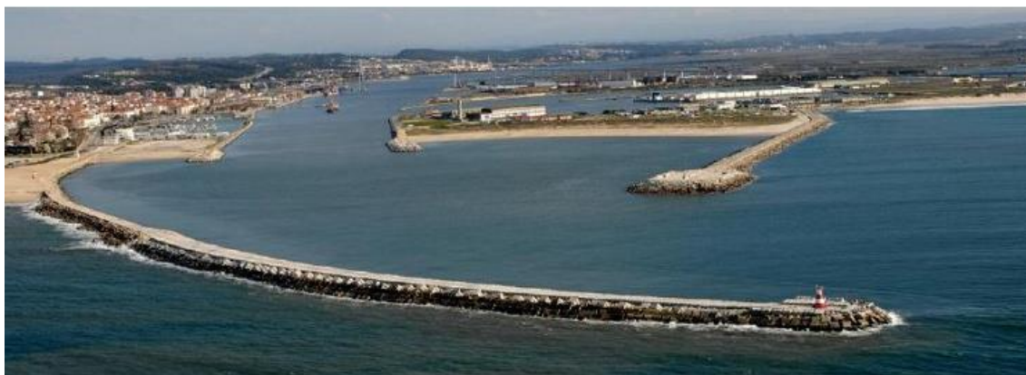
Fig. 52 - Molhes na embocadura do rio Mondego após intervenção – 2008/2010. (extraída de relatório cedido pelo Instituto Portuário e dos Transportes Marítimos, I. P.).
