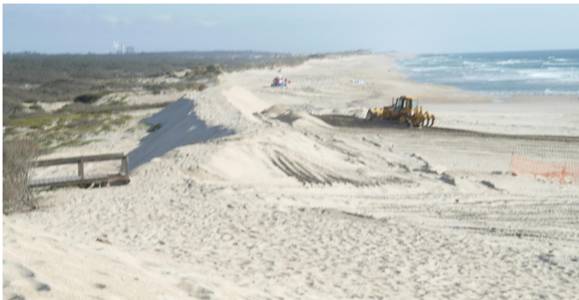
Fot. 45 – Novo cordão arenoso (2018/2019) a sul do campo de esporões da Cova/Gala. Os sacos de geotêxtil estão a ser cobertos de areia (junho de 2019).
