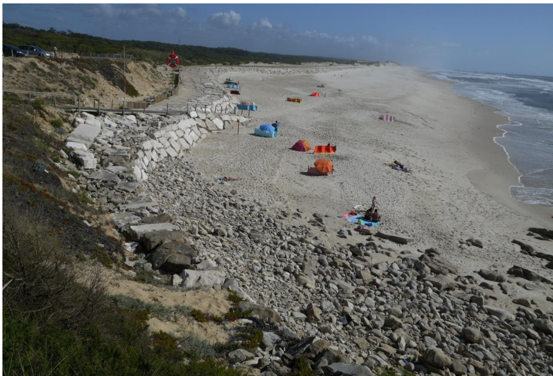
Fot. 55 – Sul do promontório do Pedrógão, defesa longitudinal aderente em enrocamento, numa extensão de cerca de 400 m (junho de 2017).
