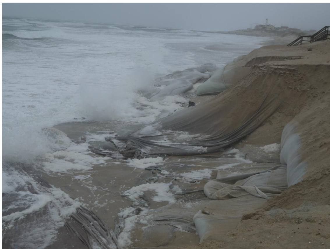
Fot. 48 – Sul da Leirosa (março de 2010) - enraizamento do emissário submarino dos efluentes das fábricas de pasta de papel, destruição dos geotubos colocados para proteção do cordão dunar frontal.
