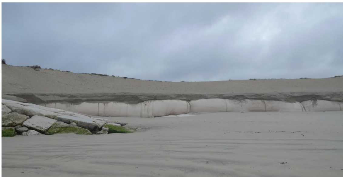
Fot. 46 – Cordão arenoso colocado no verão de 2019 a sul do campo de esporões da Cova/Gala (novembro de 2019).
