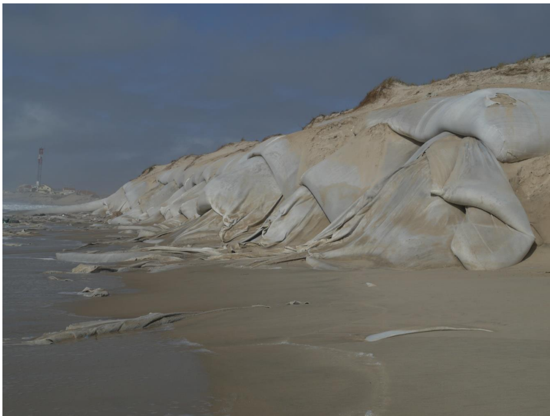
Fot. 49 – Sul da Leirosa (março de 2013) - enraizamento do emissário submarino dos efluentes das fábricas de pasta de papel, destruição dos geotubos colocados para proteção do cordão dunar frontal.
