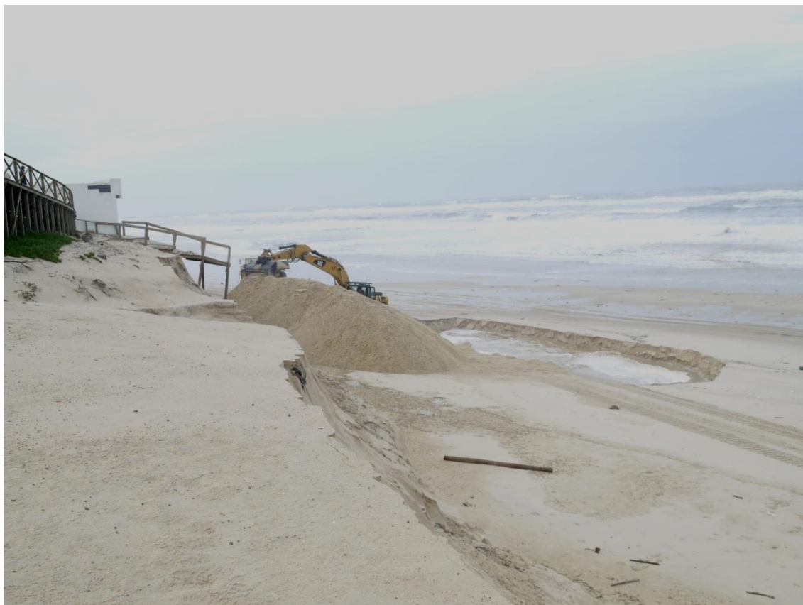
Fot. 52 – Retirada de areia da zona intermareal para formação de um cordão arenoso em substituição do cordão dunar frontal erodido (março de 2014).
