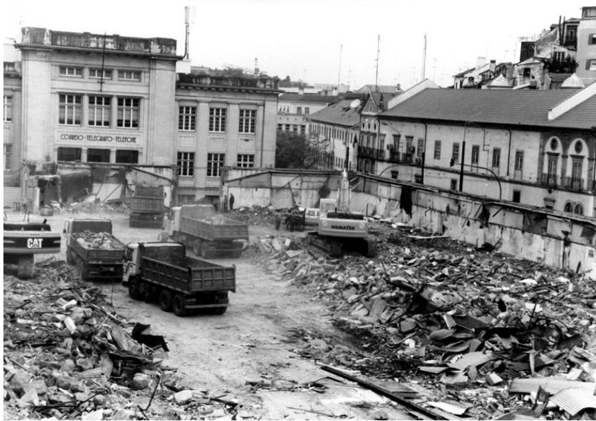
Figura 127 - Fotografia da demolição do antigo Mercado D. Pedro V. 2000.
