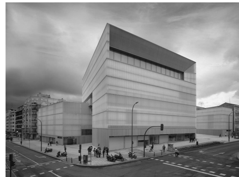
Figura 23 - Fotografia da envolvente exterior do Mercado de Barceló, Madrid. 2014.
