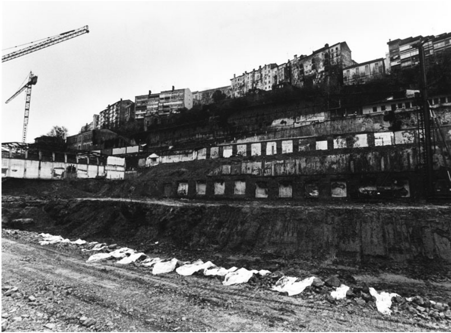
Figura 128 - Fotografia da demolição do antigo Mercado D. Pedro V. 2000.
