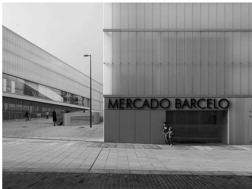
Figura 24 - Fotografia da envolvente exterior do Mercado de Barceló, Madrid. 2014.
