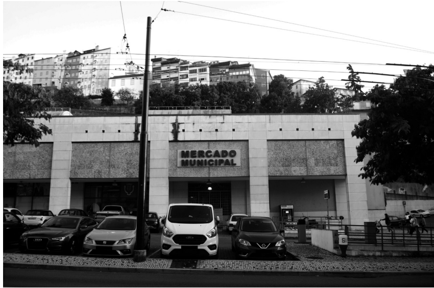
Figura 108 - Fotografia do estacionamento do Mercado Municipal - Alçada norte [Piso 0].
