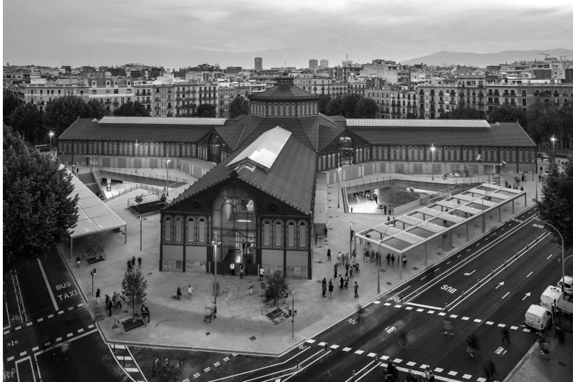
Figura 15 - Fotografia da envolvente exterior do Mercado de Sant Antoni, Barcelona. 2018.
