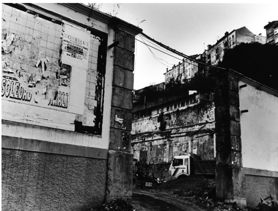
Figura 136 - Fotografia da demolição do antigo Mercado D. Pedro V. 2000.
