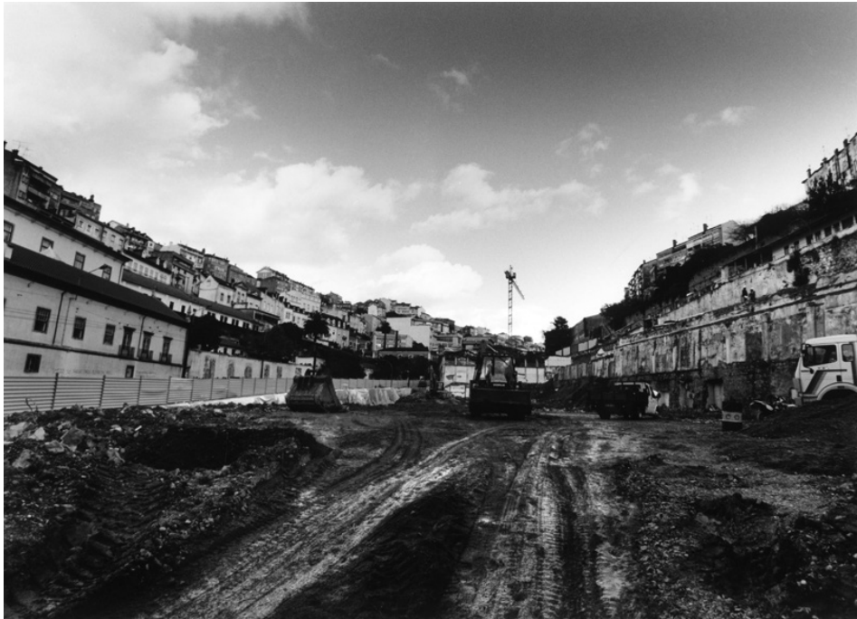
Figura 101 - Fotografia da demolição do antigo Mercado D. Pedro V. 2000.
