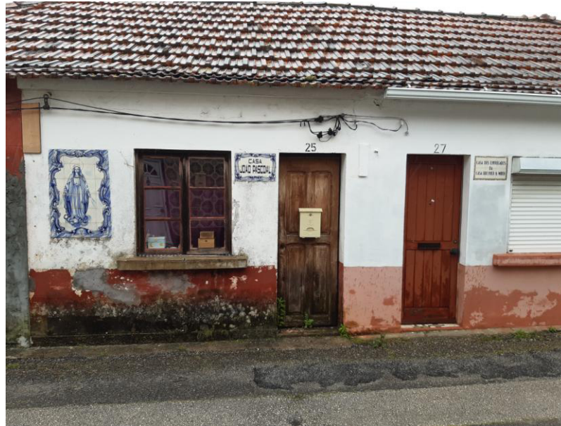
Figura 2: Casa dos Empregados da Casa Breyner & Wirth e Casa João Pascoal
