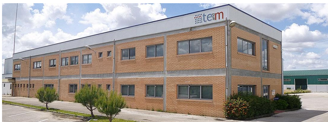
Figura 2.1. Instalações da empresa TEandM (Adaptado de TEandM - Tecnologia e Engenharia de Materiais, S.A.).
