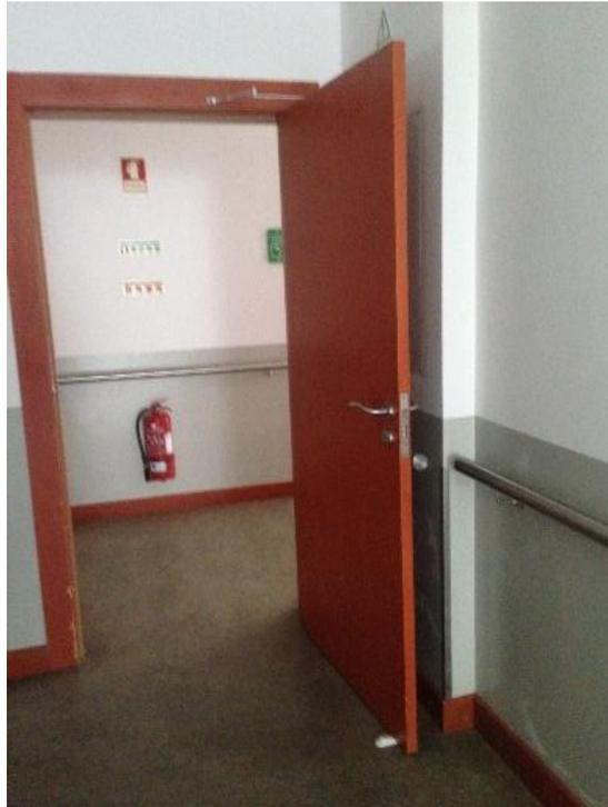
**Figura 4.6 - Porta com dispositivo de fecho e cunha impedindo o seu fecho**
