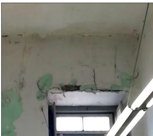
Figura 13 - Fissuração em janela (pormenor 2)
