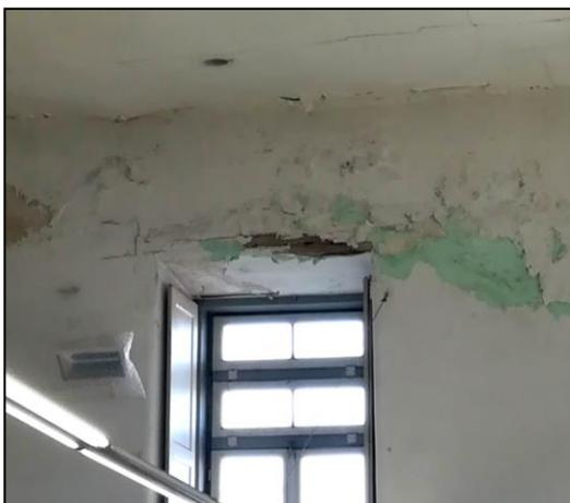
Figura 11 - Fissuração em janela (pormenor 1)
