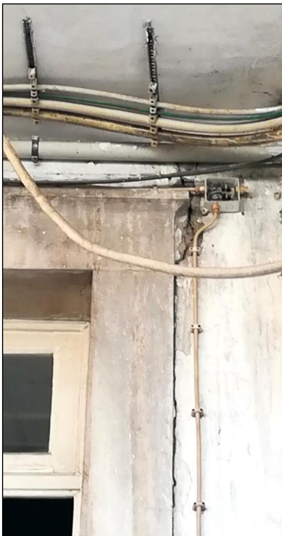
Figura 12 - Pormenor de fissuração (pelo exterior)
