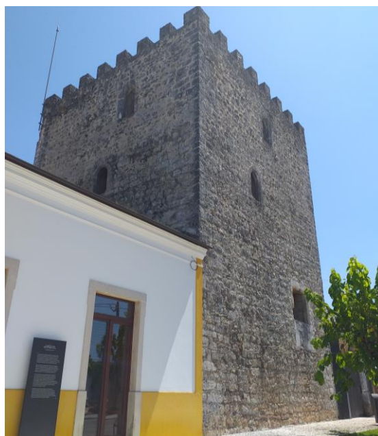
Figura 12: Torre Medieval do Complexo de Santiago da Guarda
