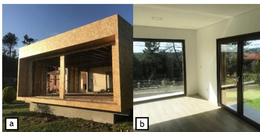
Figura 2.4 – Painéis de revestimento: a) placas de OSB; b) placas de gesso cartonado (Futureng, 2020b).
