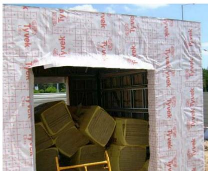
Figura 2.8 – Membrana de estanqueidade ao ar (Soares *et al.*, 2017).
