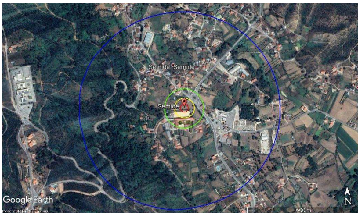
Figura 48 - Imagem satélite do local de lançamento em Semide.
