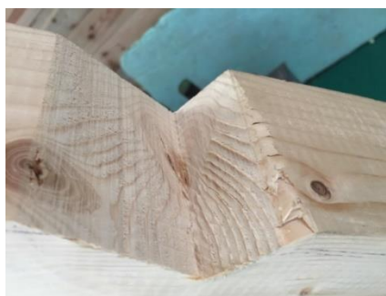
Figura 4.8 - Rotura por compressão 3-SP-C
