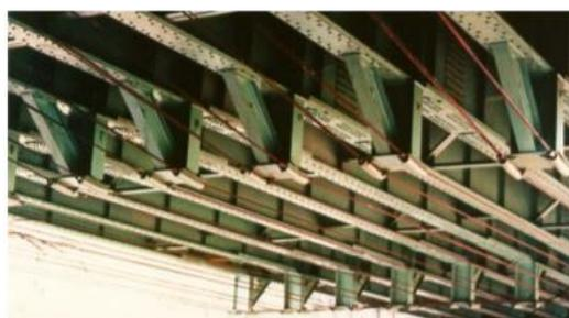
Figura 2.91 - Solução mista pré-esforçada – Ponte de Condet – Indonésia (Nelsen & de Souza, 2012)
