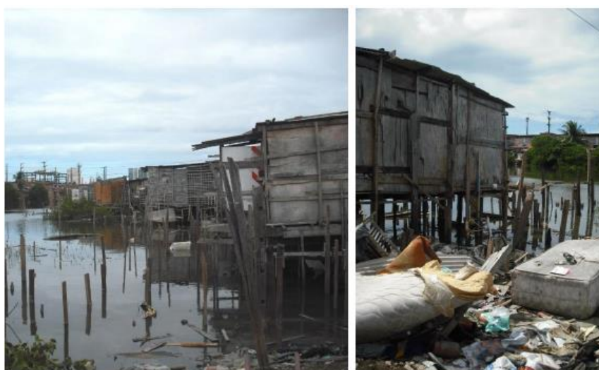
Figura 4: Palafitas na região dos Coelhos em Recife. Fonte: Neto (2016).
