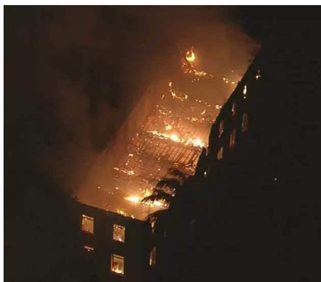
Figura 7: Incêndio no prédio do MPC em 2014. Fonte: G1 – Globo on-line (2014)
