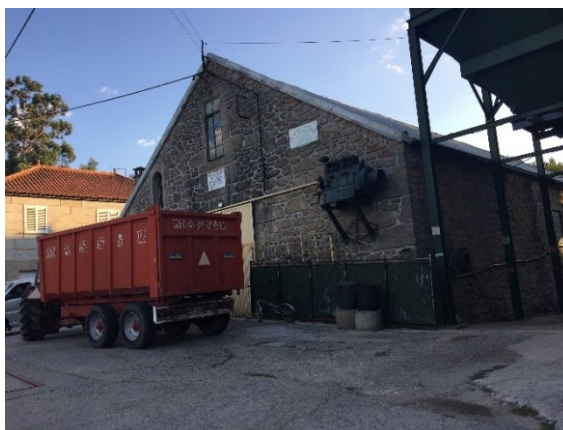
Figura 6.33 – Vista geral do edifício construído no local da Central de Cogula
