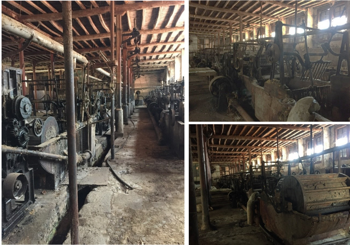
(a) (b)/(c) Figura 6.42 – Lavadouro mecânico da fábrica de S. Gabriel. (a) Vista geral do lavadouro, (b) (c) Pormenores do lavadouro.
