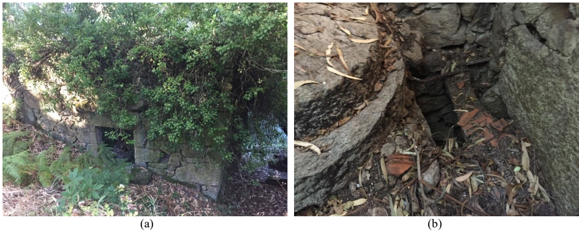
Figura 6.39 – Ruínas da central de S. Paio.
