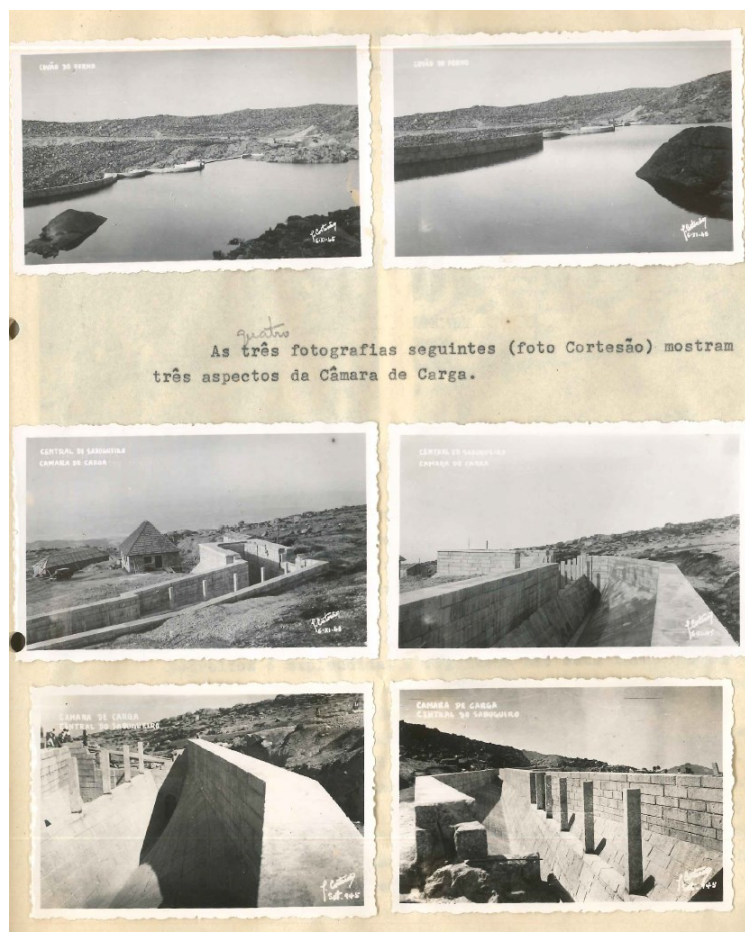
Figura 5.19 – Excerto relatório de acompanhamento das obras associadas à Central do Sabugueiro Camãra de Carga, pág. 2 (Fonte: © EDP, Gestão da Produção, Centro de Produção Cávado Lima e Centro de Documentação da Fundação EDP 324 )
