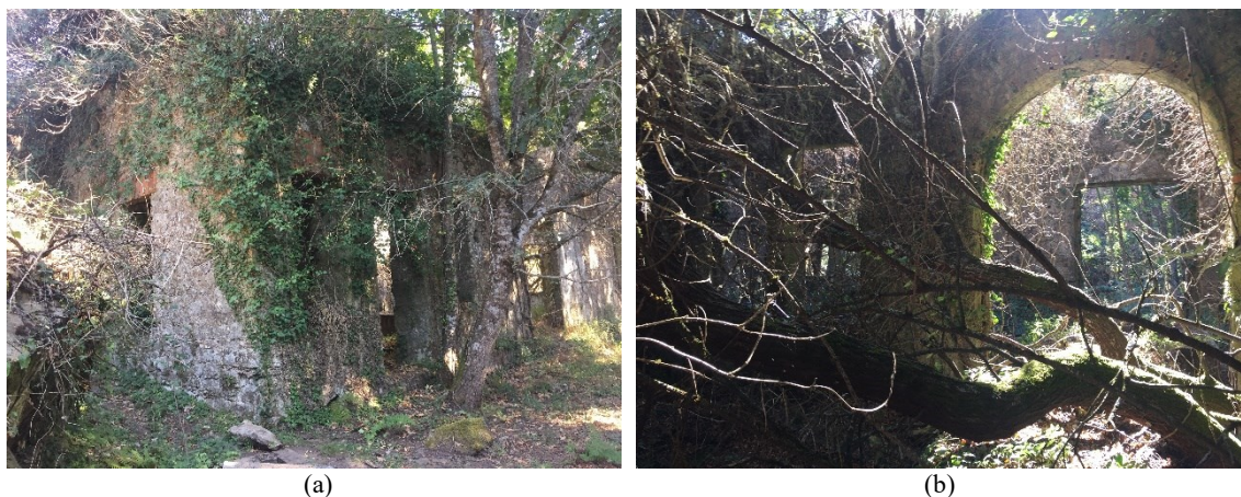
(a) Vista geral do edifício, (b) Vista a partir do interior do edifício.
