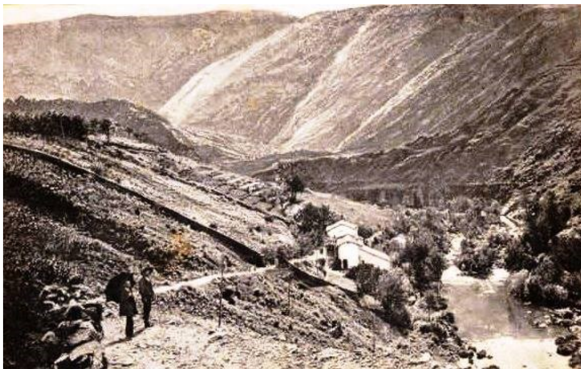
Figura 5.1 – Vista da Central do Pateiro – Postal
