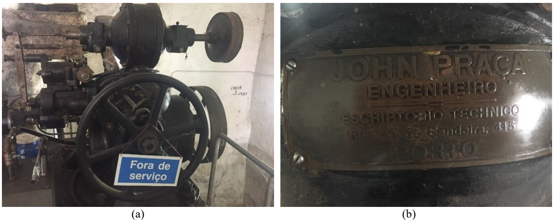
Figura 6.14 – Antigo equipamento de regulação de velocidade da Central de Riba-Côa.
