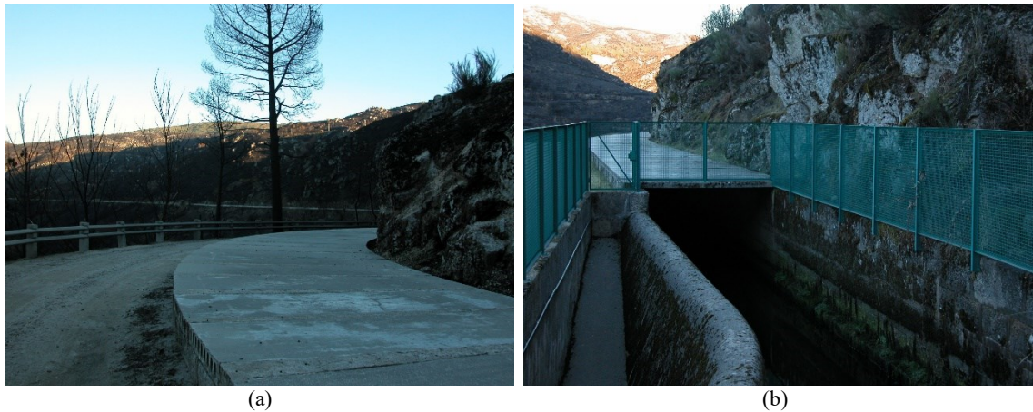
Figura 6.18 – Canal de alimentação da câmara de carga da Central da Senhora do Desterro II.
