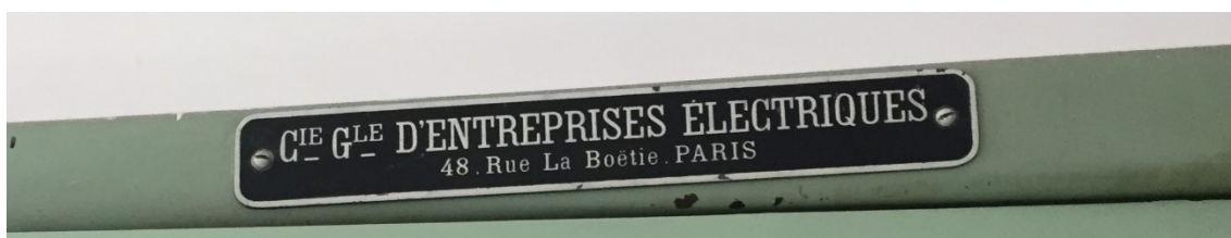
Figura 6.30 – Pormenor do quadro de comando e controlo inicial da central de Sabugueiro I.
