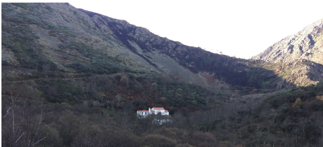
Figura 6.6 – Vista da Central do Pateiro.
