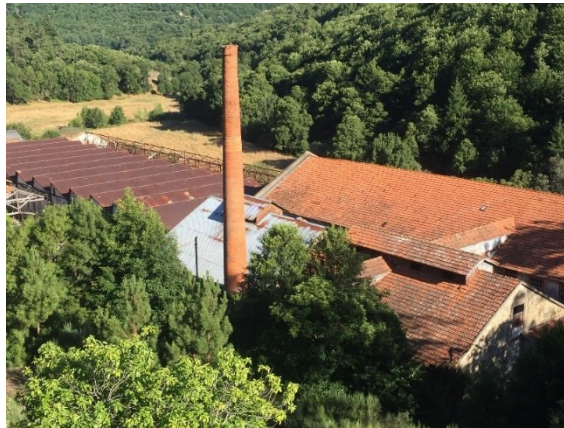
Figura 6.41 – Vista geral da fábrica de lanifícios S. Gabriel.
