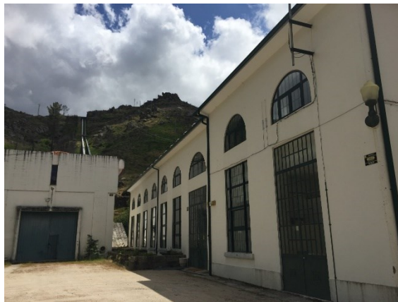
Figura 6.26 – Centrais do Sabugueiro. Edifício da central do Sabugueiro I à direita e Sabugueiro II ao fundo à esquerda.
