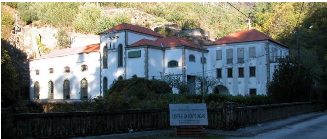
Figura 6.19 – Edifício da Central de Ponte Jugais.
