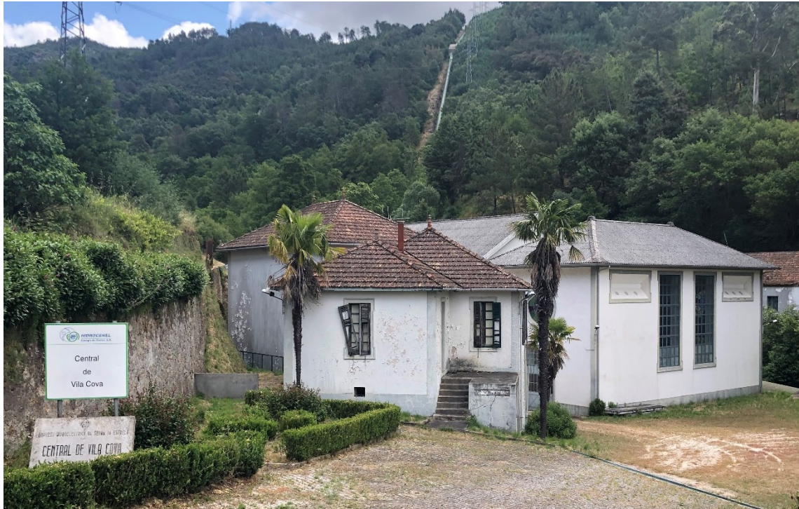
Figura 6.22 – Entrada da Central de Vila Cova.
