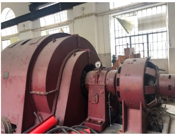
(a) (b) Figura C.14 – Gerador Alsthom da central de Vila Cova. (a) Vista geral (b) Pormenor da chapa de características, 8900kVA.
