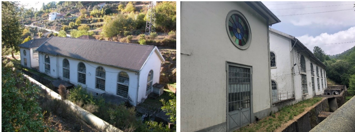
(a) (b) Figura 6.23 – Vista posterior do edifício da sala de máquinas da Central Vila Cova. (a) Vista geral (b) Pormenor da construção – vitral numa janela
