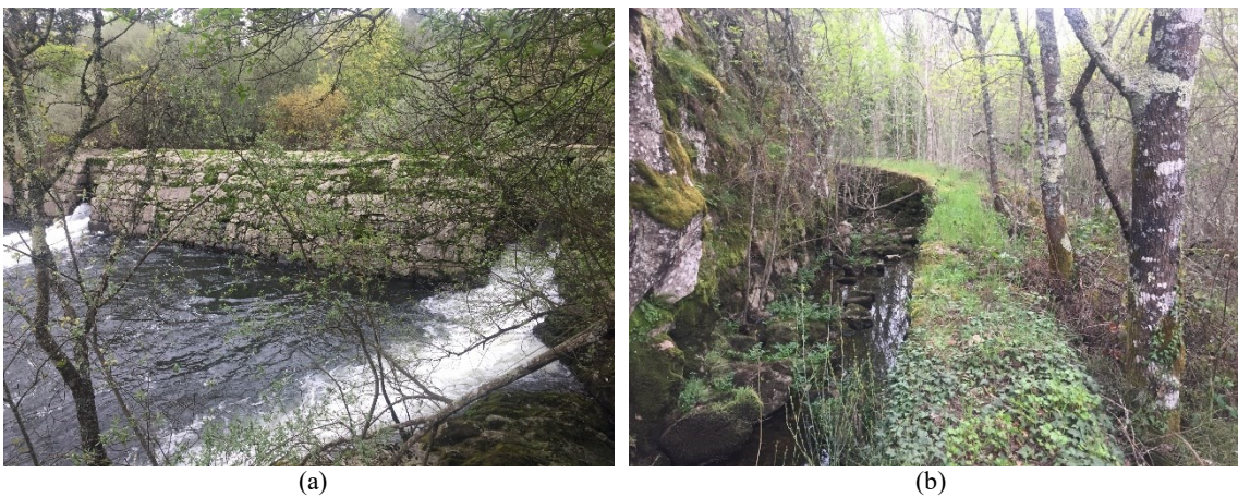
Figura 6.32 – Sistema de abastecimento hídrico da Central de Pantaleão.
