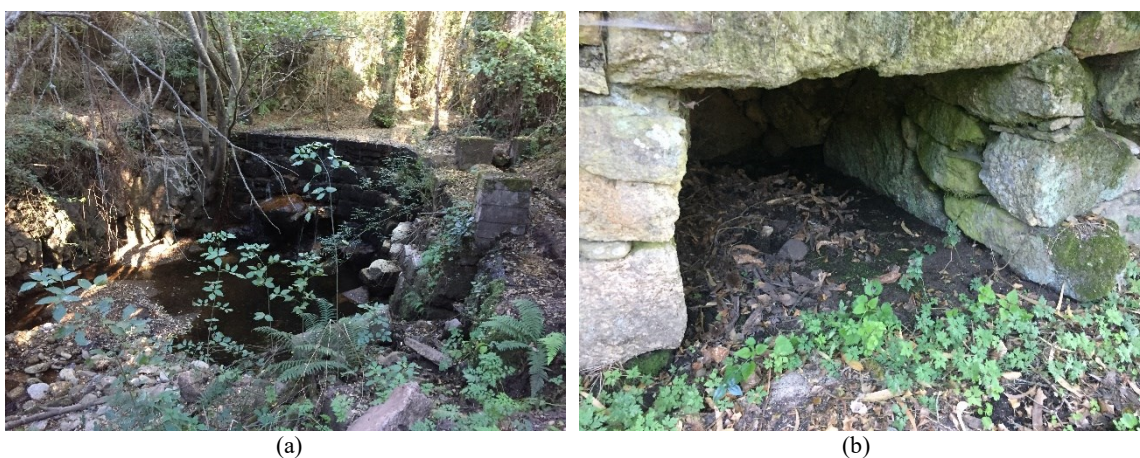
Figura 6.40 – Vestígios do sistema de abastecimento hídrico da central de S. Paio.
