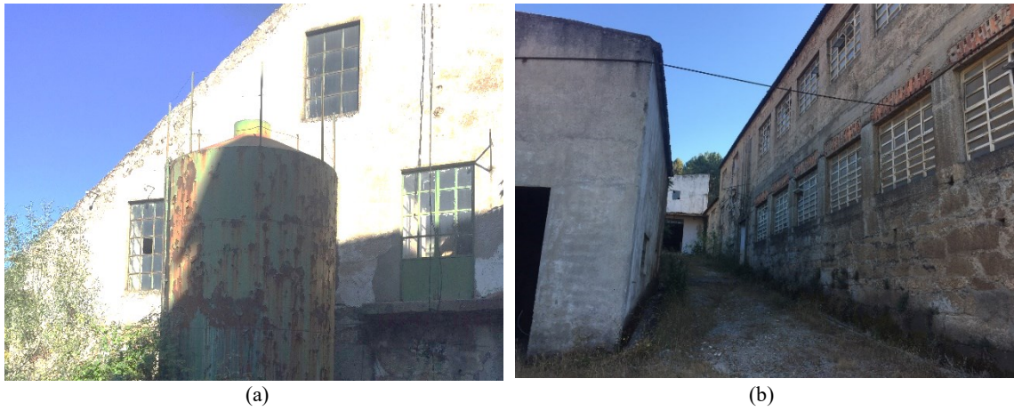
Figura 6.38 – Edifícios de antiga fábrica de lanifícios, em S. Paio, Gouveia (a) (b).
