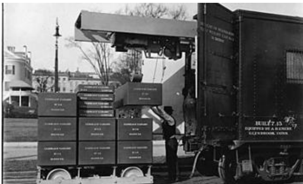
Figura 9: Em 1913, o NIST trabalha no aperfeiçoamento dos testes em balanças ferroviárias (Foto: NIST)
