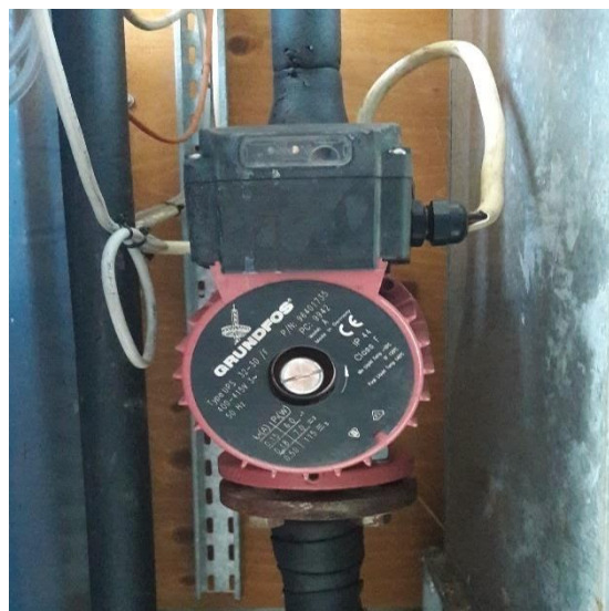
Figura 49 - Instalação da bomba do GTA IV no GTA III
