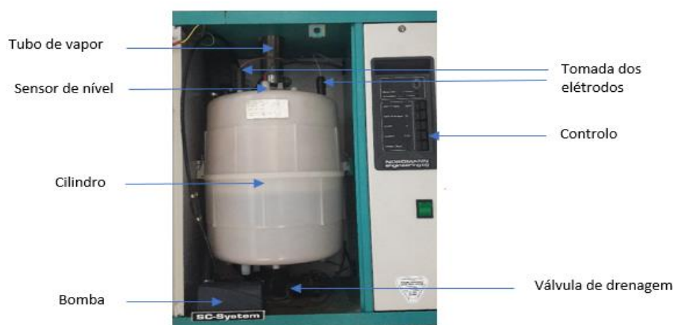
Figura 23 - Constituintes do Humidificador NOVAP 3000
