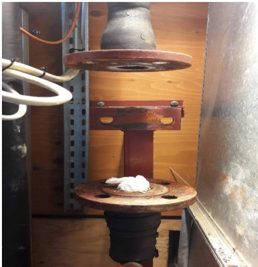
Figura 48 - Remoção da bomba circulatória danificada
