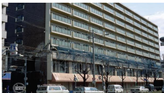
Figura 2.10 – Colapso total do 3º piso, sismo de Kobe (Japão) 1955 [ Fonte: (Chastre et al., 2012)].
