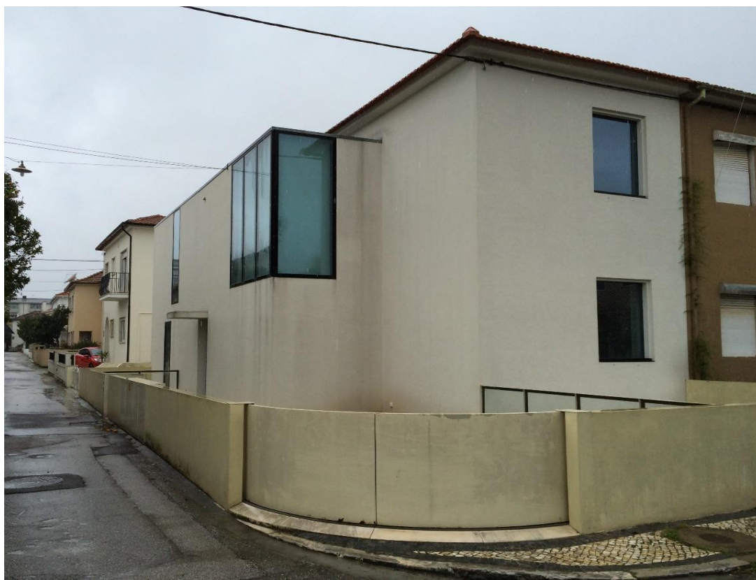
Figura 5.3- Vista geral do edifício unifamiliar
