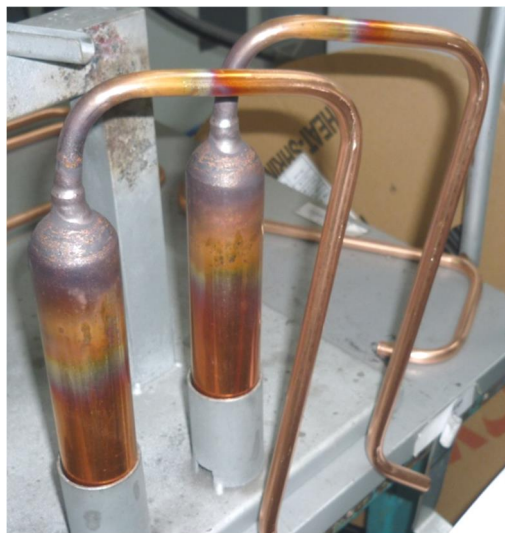
Figura 33 - Operação de soldadura capilar tubo de cobre
