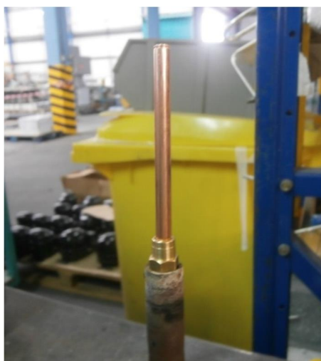
Figura 22 - Operação de soldadura válvula de carga - tubo de cobre
