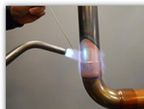
A capilaridade permite a união das peças através do contacto das mesmas com o material derretido
