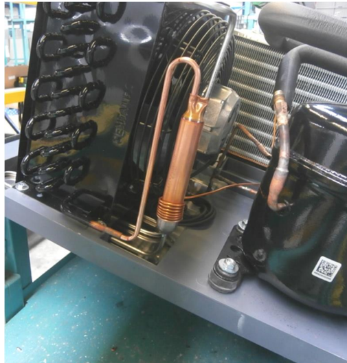
Figura 32 - Operação de soldadura condensador tubo de cobre
