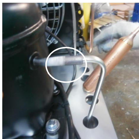
Figura 24 - Operação de soldadura saída do compressor - serpentina de inox
