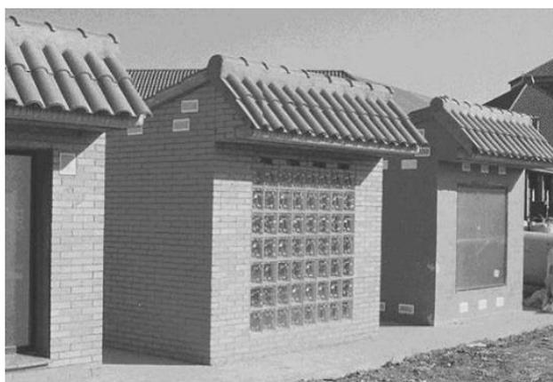
Figura 3.14 – Parede de Trombe com PCMs incorporados nos materiais [27].
