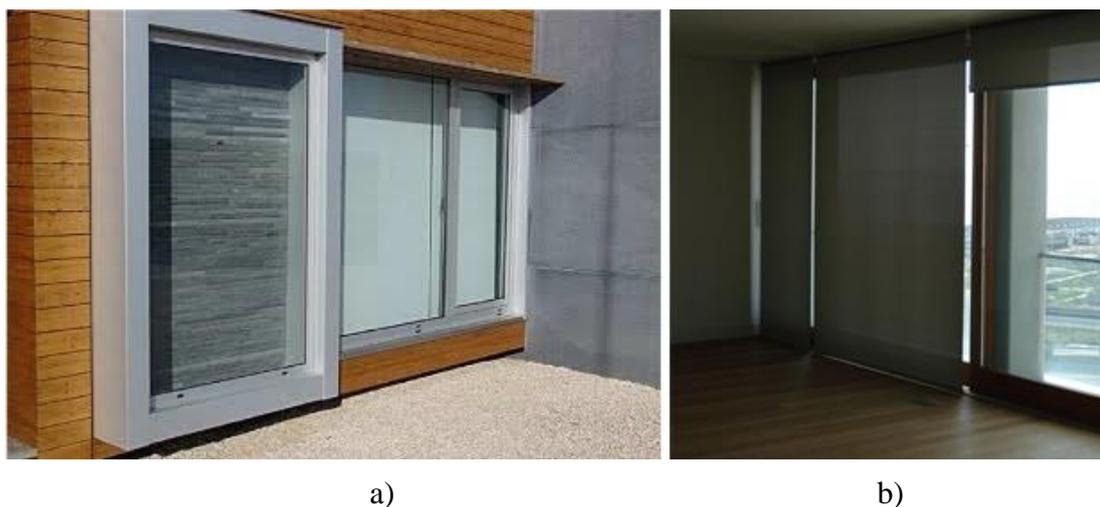
Figura 3.4 – Exemplo de sistemas de sombreamento. a) Pala exterior [20], b) Estores [21].
