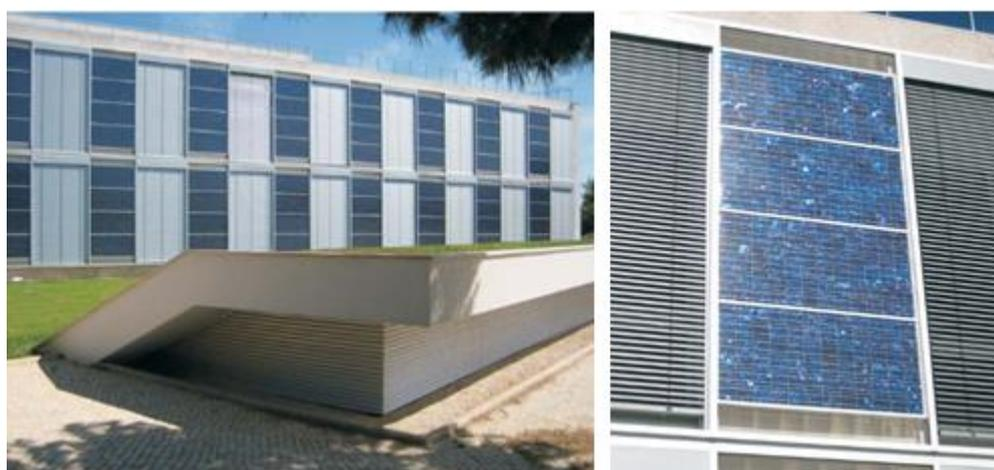
Figura 3.11 – Parede fotovoltaica do edifício solar XXI do INETI [26].
