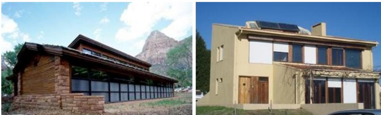
Figura 3.1 – Exemplo de uma parede de Trombe [9] [10].
