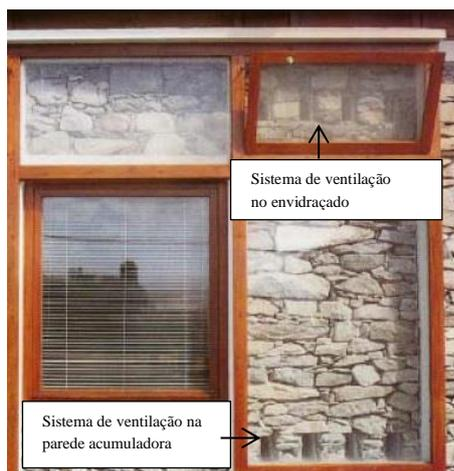
Figura 3.6 – Sistema de ventilação duplamente ventilado. Adaptado de [9].
