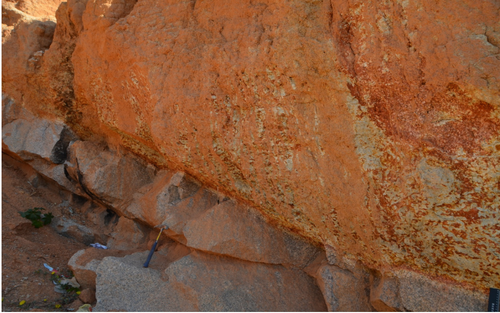
Figura 4.5 - Granito medianamente a muito alterado. .
