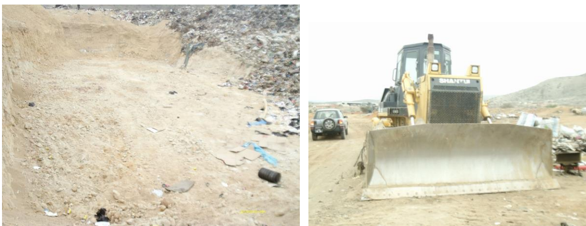
Figura 13 - Célula da lixeira e máquina para enterrar resíduos.
