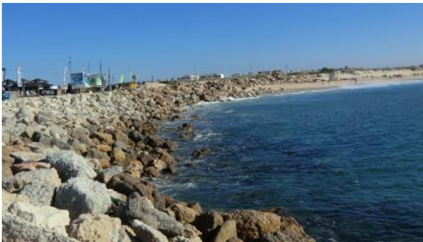
Figura 3.1 – Representação de enrocamento.
