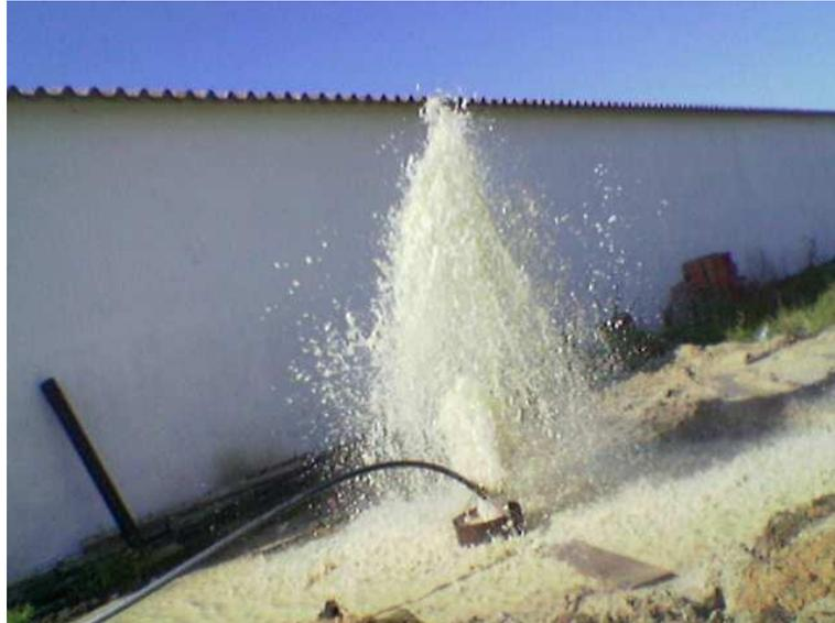
Figura 4.16 - Limpeza e desenvolvimento da captação (Captação em Benavente – Santarém).
