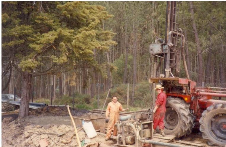
Figura 4.9- Exemplo de uma perfuração a rotação por circulação direta.
