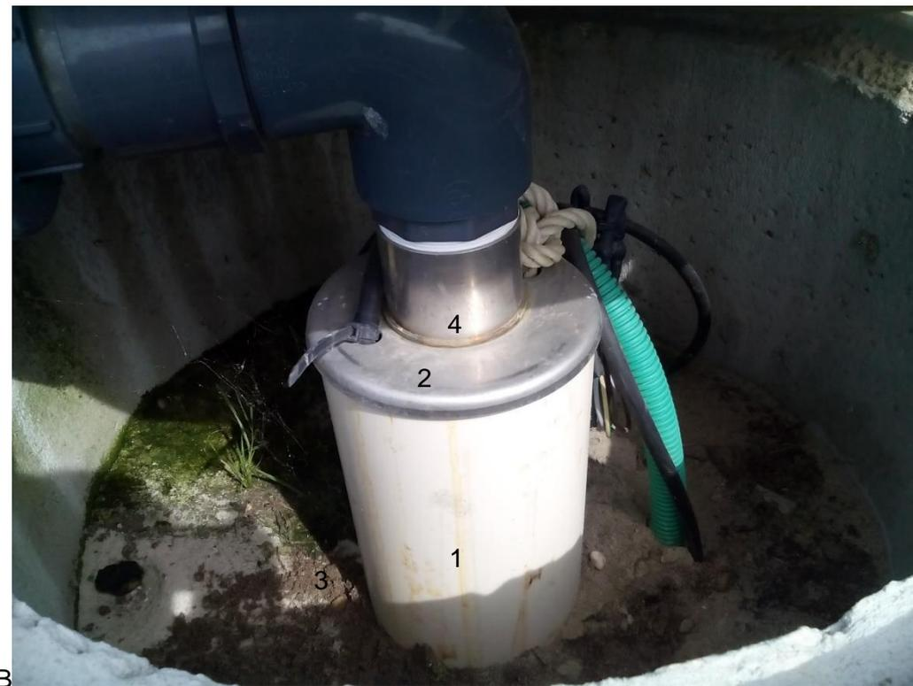
Figura 4.5 – A - Furo F19 e a sua envolvente; B – Pormenor do Furo F19 (1) – Tubo de PVC; (2) – Tampa de proteção; (3) – isolamento superficial (camuflado pela areia); (4) – Conduto de elevação da electrobomba submersível.
