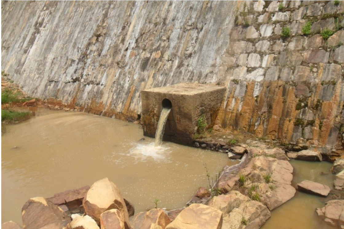
Figura 3.5. Descarregador de fundo da barragem das Neves.
