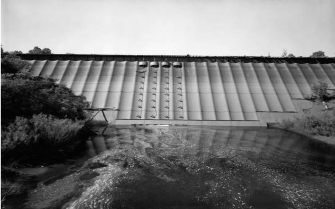
Figura 1.1. Vista de montante da barragem de Redridge Steel, E.U.A. (Jesus, 2011).
