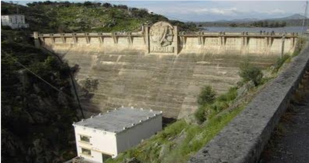
Figura 1.3. Vista do paramento de jusante da barragem de Idanha (Portugal) (Jesus, 2011).
