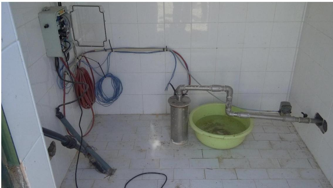
*Figura 25- Aspeto do furo AC2: tubagem em aço inox, e respetivo equipamento para bombagem e canalização da água.*
