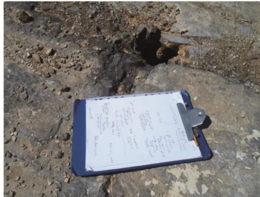
Pequeno sinkhole - pedreira - Pena Junho de 2015
