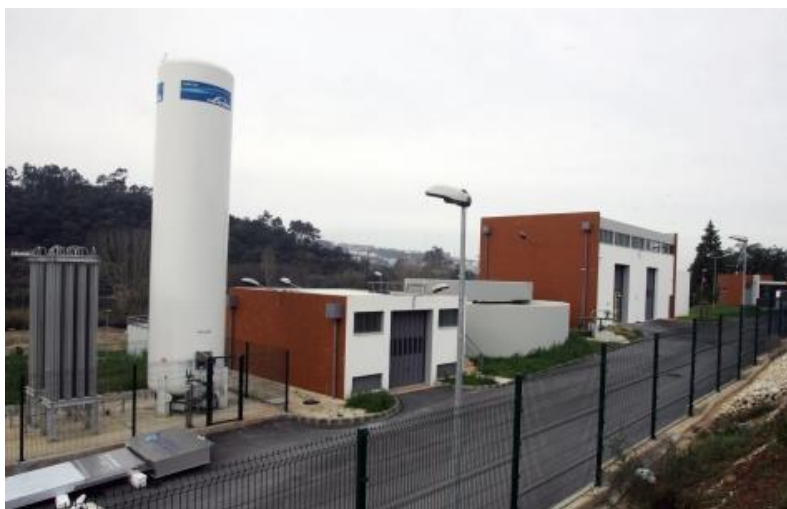
Figura 1.1 Instalações da Empresa Águas do Mondego S.A.
