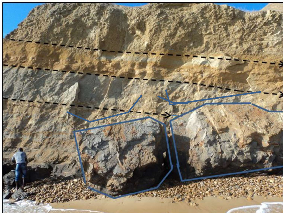
Figura 5.4 – Panorâmica da Estação Ila, em que se observam diversos desmoronamentos (quedas de blocos).
