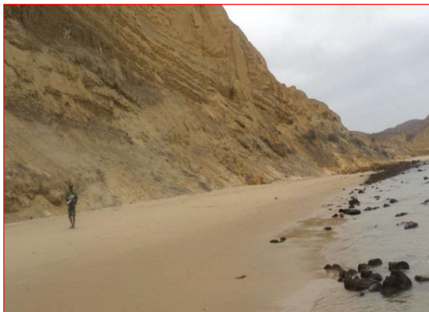
Figura 5.6 - Panorâmica de arriba da estação IIIa em que se observam movimentos de instabilidade e depósitos de cobertura.
