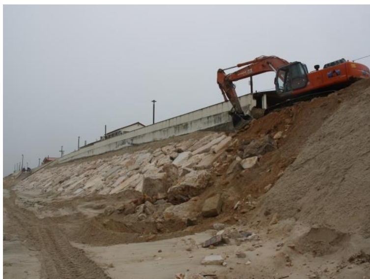
Figura 48 - Obra de reforço do paredão da Praia da Vieira (18DEZ2013)
