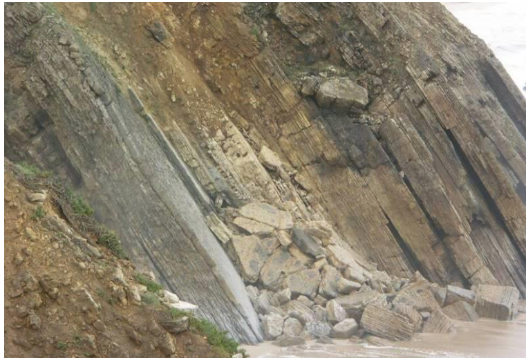
Figura 47 - Deposição de detritos na base da arriba
