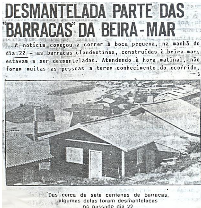
Figura 7 - Extrato de notícia a demolição de barracas Fonte: Jornal da Marinha Grande, n.º 98, de 30 de dezembro de 1982
