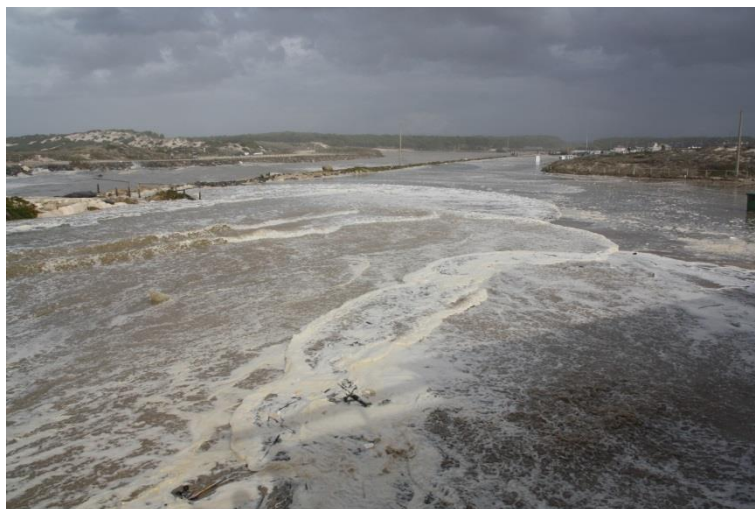
Figura 41 - O mar chegou ao parque de estacionamento da margem direita do rio Lis
