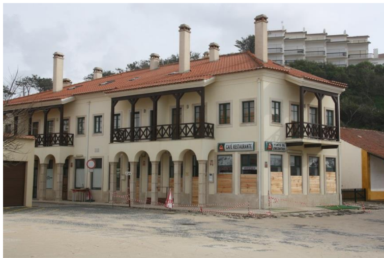
Figura 59 - Edifício com proteções nas portas e janelas
