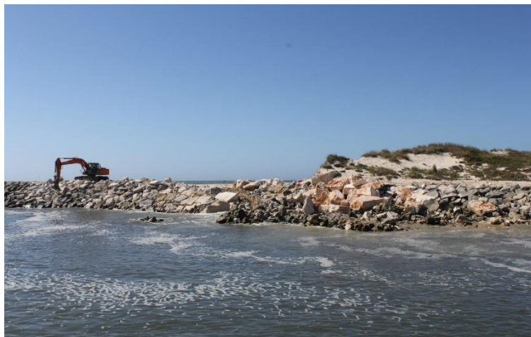
Figura 49 - Obra de reparação do molhe norte do rio Lis (14AGO2014)
