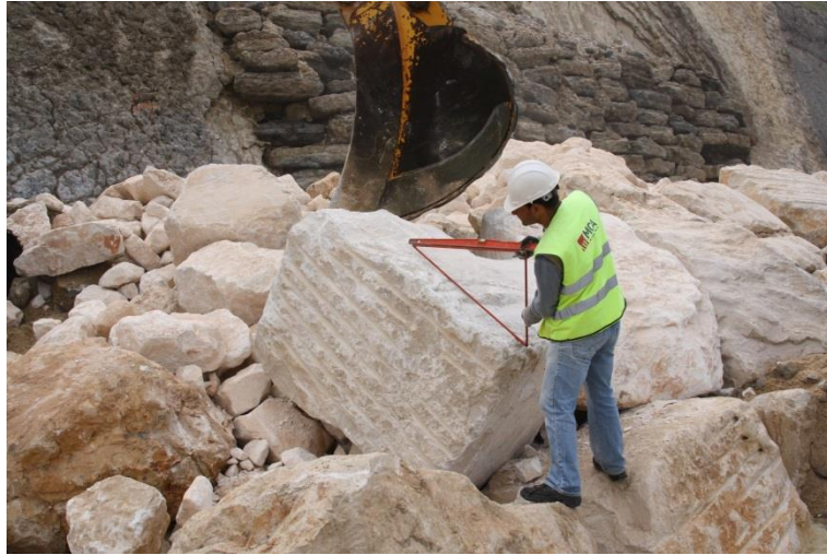
Figura 57 - Verificação do ângulo durante a execução da proteção aderente
