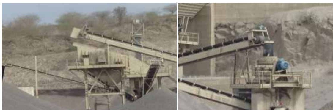
Figura 4.19 - Aspectos gerais da central de britagem da pedreira de Uche.
