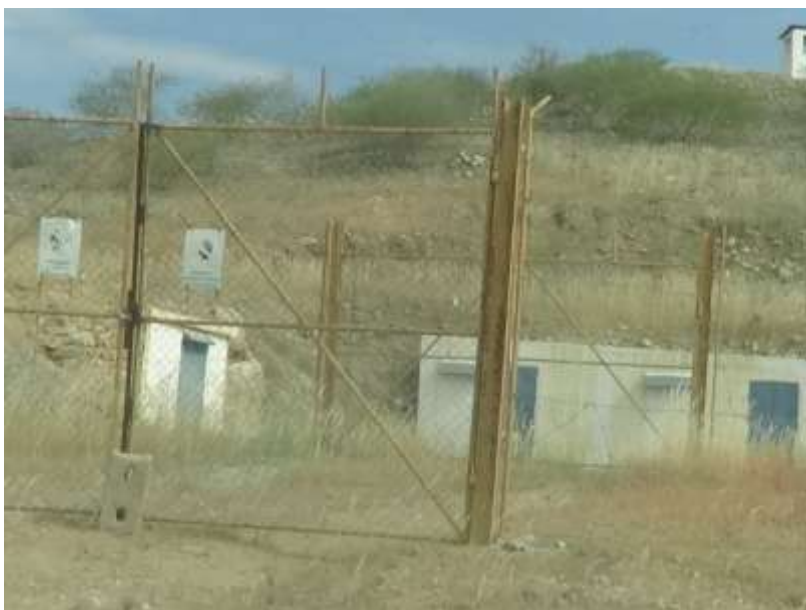
Figura 4.22 - Área do paiol de explosivos e respetivas vedações para proteção do espaço.
