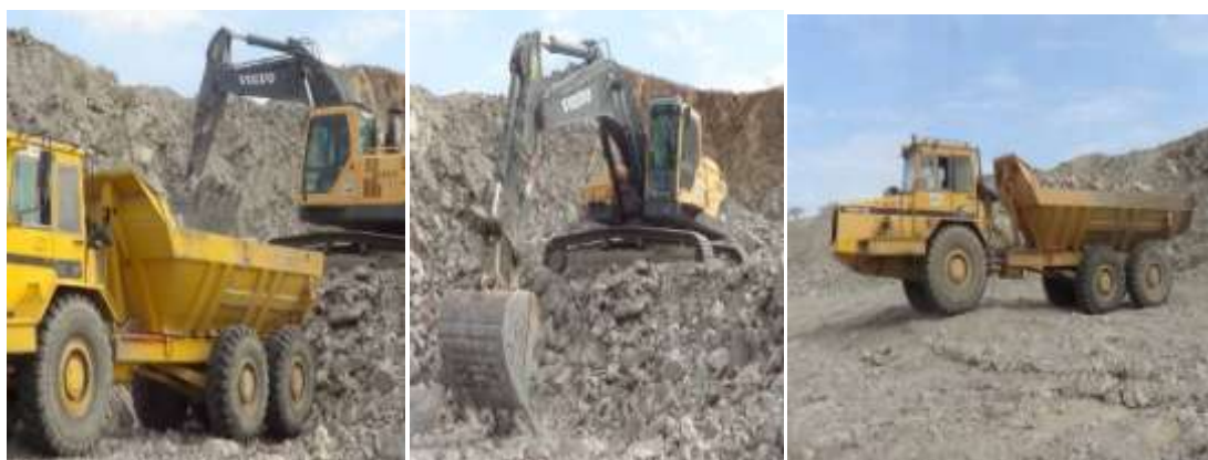
Figura 4.18. Equipamentos (escavadora giratória e Dumper em operação de carregamento).
