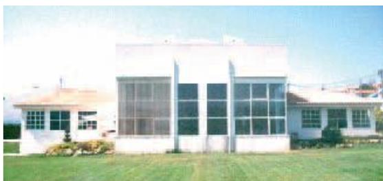
Figura 2.22 – Parede de armazenamento nas casas de Jade (adaptado de Gonçalves e Graça, 2004).
