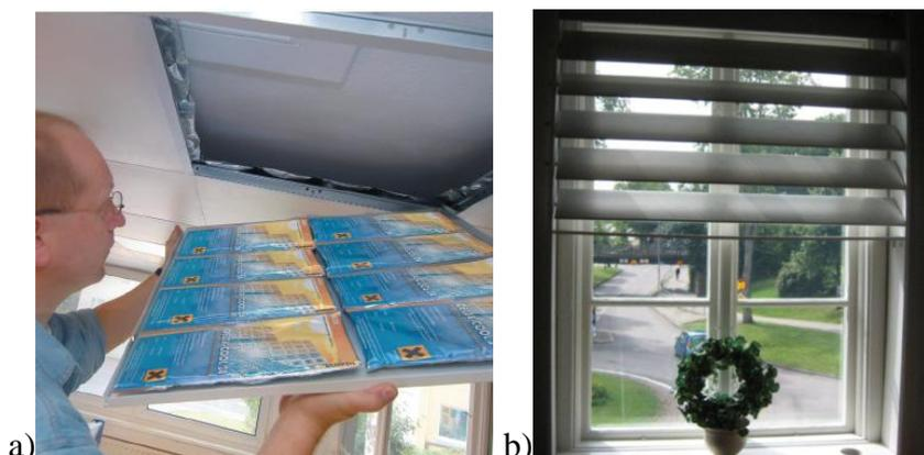
Figura 2.34 - Exemplos de aplicação de PCM's: a) Em tetos falsos (DELTA-COOL 24@, 2011 apud Santos et al., 2012); b) Em lamelas interiores de janelas (Glauber-lamell AB@, 2011 apud Santos et al., 2012).
