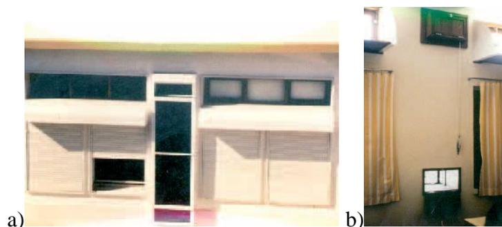
Figura 2.28 – Coletor a ar: a) Vista exterior; b) Vista interior (Gonçalves e Graça, 2004).
