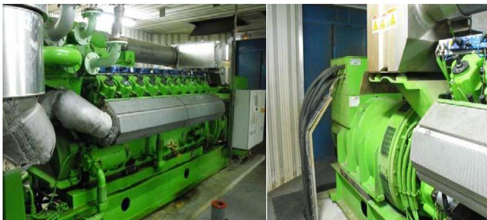
Figura 10 - Motor a GN e alternador
