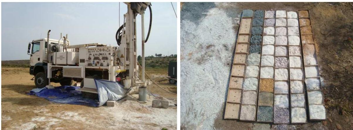
**Figura 4.3: Construção da captação e fragmentos de perfuração (*cuttings*) do Furo 7.**
