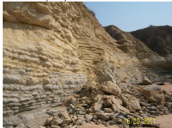
D – Exemplo de deslizamento translacional em cunha no sector 3 (Secil)
