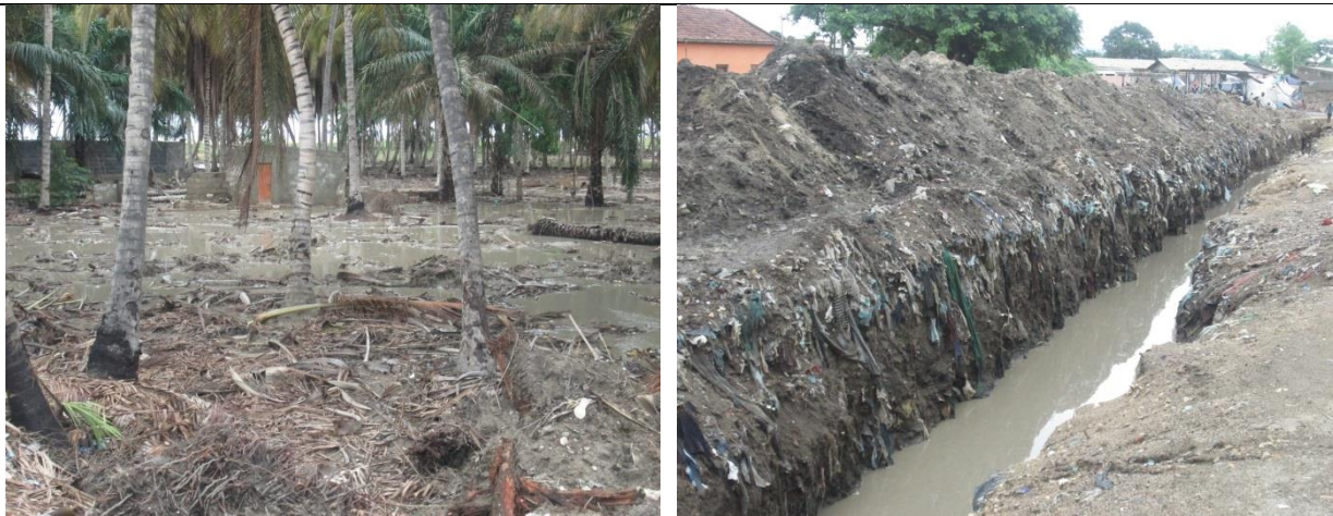
Figuras 2.26 e 2.27 Aspectos da contaminação de solos e águas associada ao aterro sanitário do Bairro do Quioche
