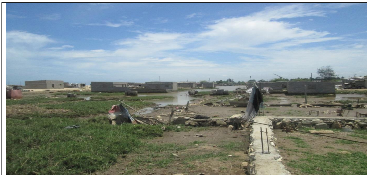
Figura 2.10 Aspecto dos impactos da inundação do rio Cavaco no Bairro do Tchipiandalo
